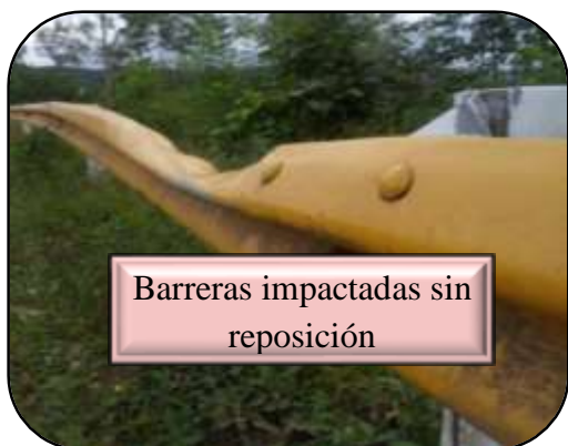
La pintura no fue reparada, esta es importante para la visibilidad de los conductores
