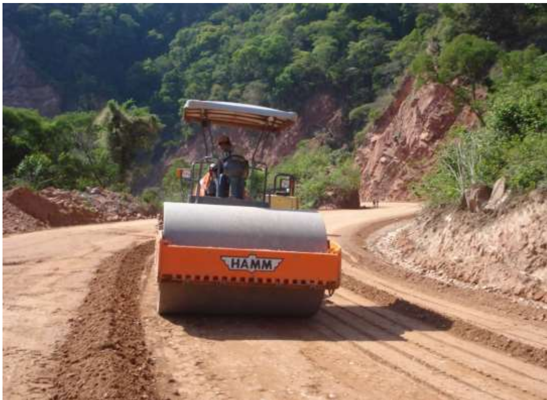
Figura 4.13. Compactando con rodillo liso.
