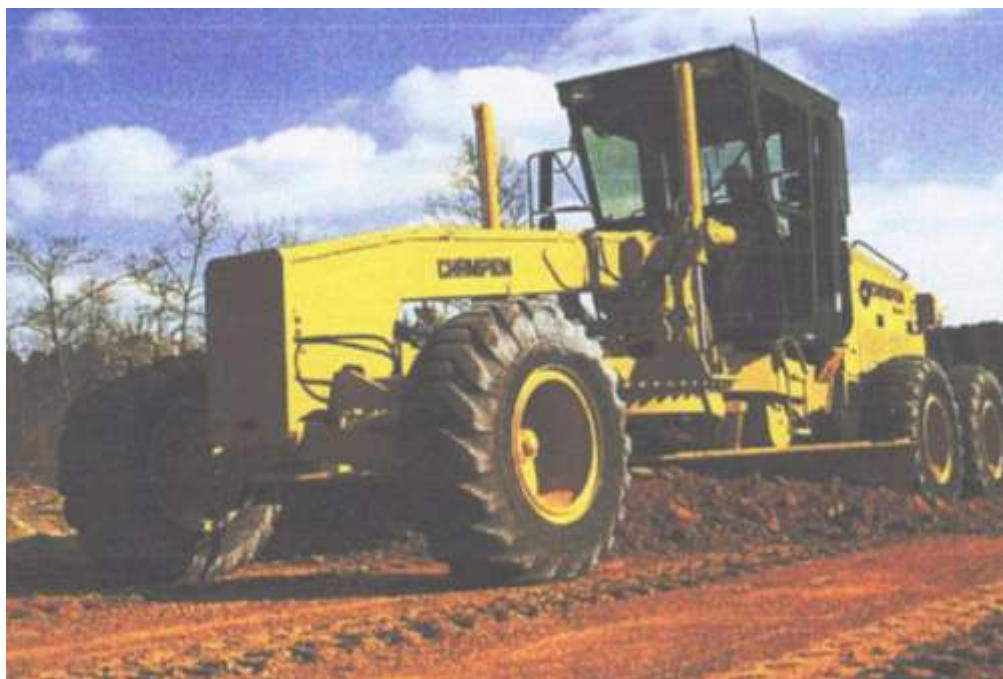
MOTONIVELADORA PERFILANDO LA EXPLANADA MEJORADA
