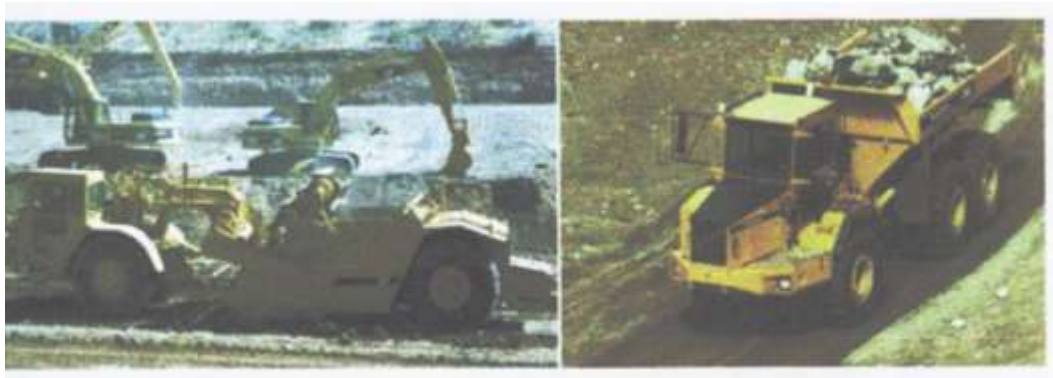
MAQUINARIA EMPLEADA EN EL TRANSPORTE Y EXTENDIDO DE TIERRAS
