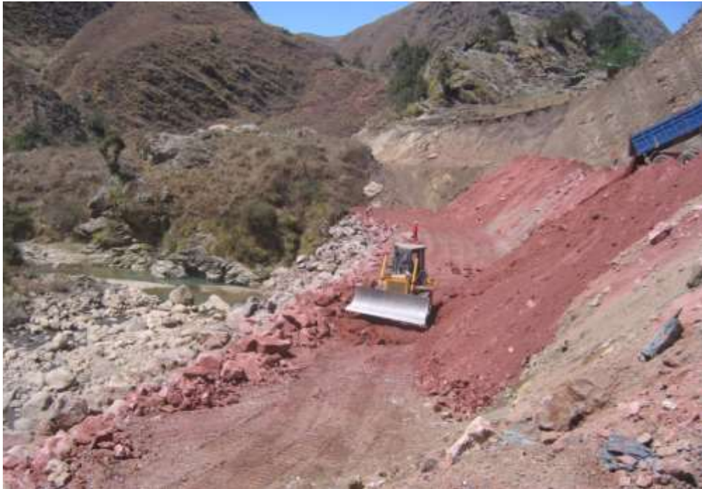
Figura 4.10. Nivelado de capa de Pedraplén progresiva 1+880
