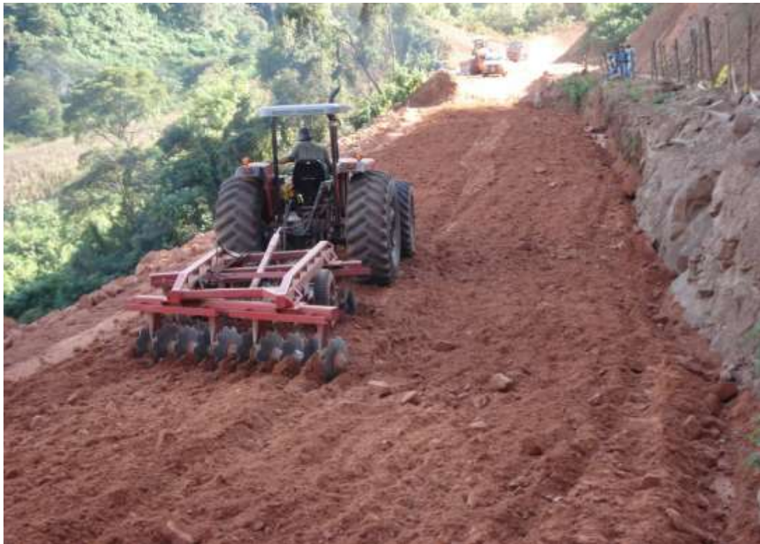
Figura 4.11. Procesando material para homogenizar.
