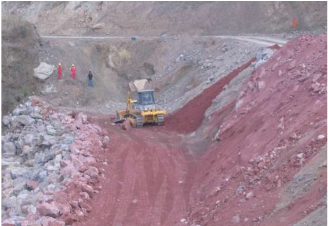
Figura 4.9. Extendido y Apisonado progresiva 1+880
