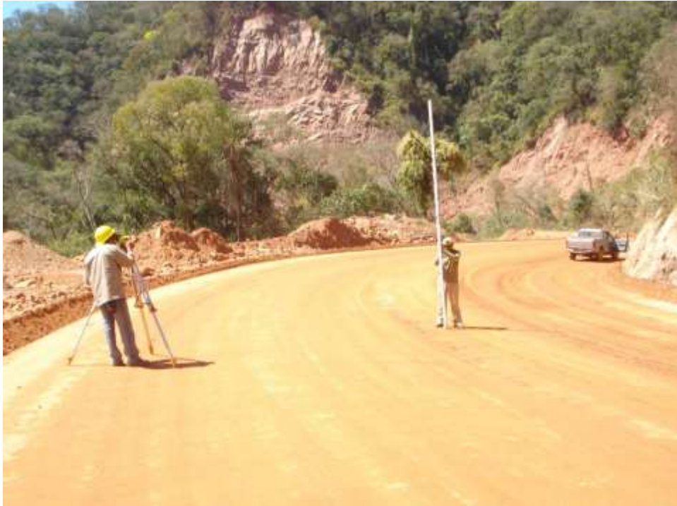
Figura 4.16. Nivelación y control topográfico.
