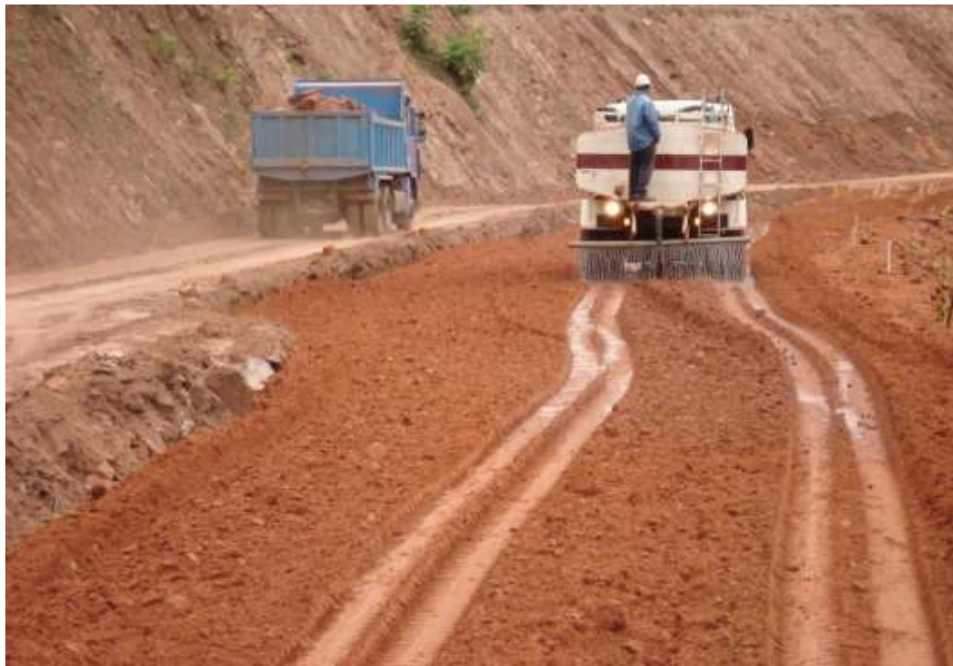
Figura 4.12. Camión cisterna regando para tener la humedad óptima.
