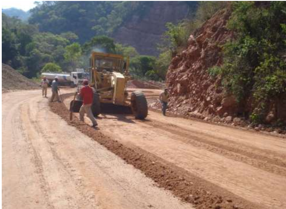
Figura 4.14. Motoniveladora perfilando la capa de terraplén.
