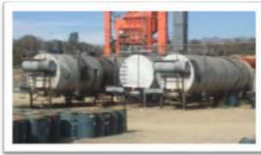
Fig.5 Planta de Áridos Charaja Fuente: Elaboración Propia
