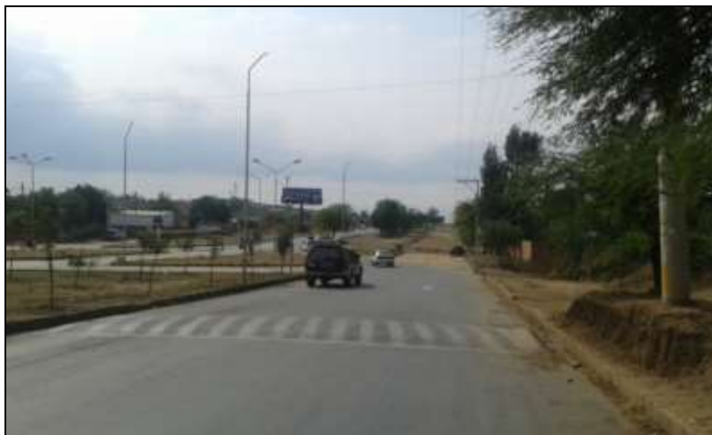
Figura 4.10. Tramo Final D-E
