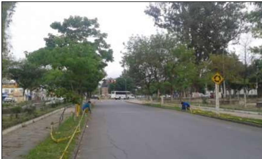
Figura 4.8. Tramo Final C-D
