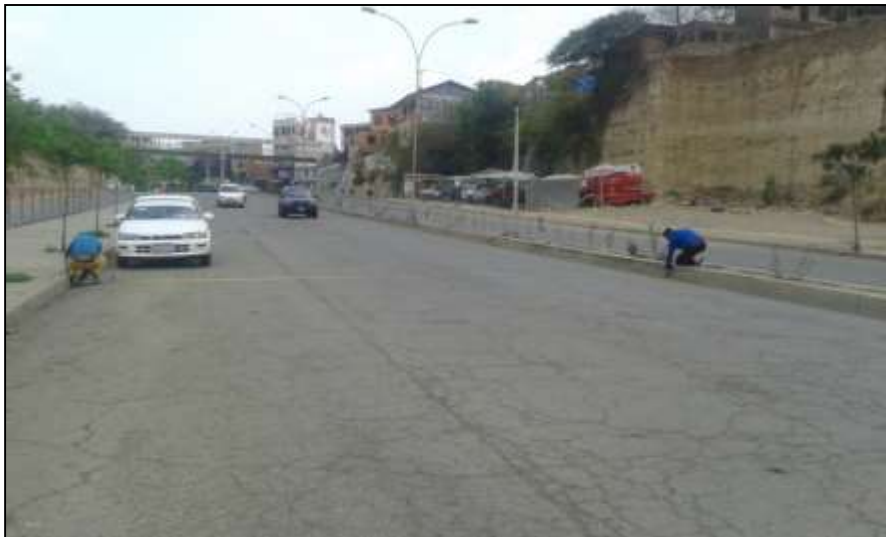
Figura 4.6. Tramo Final A-B
