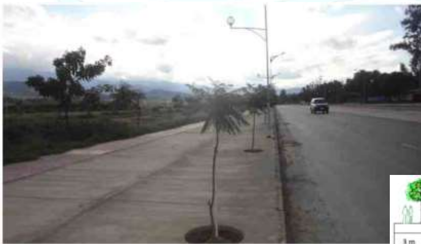
Vía de primer orden – Avenida Integración.
