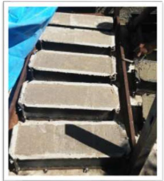
*Fot.3.17. Preparado de las vigas de hormigón convencional*
