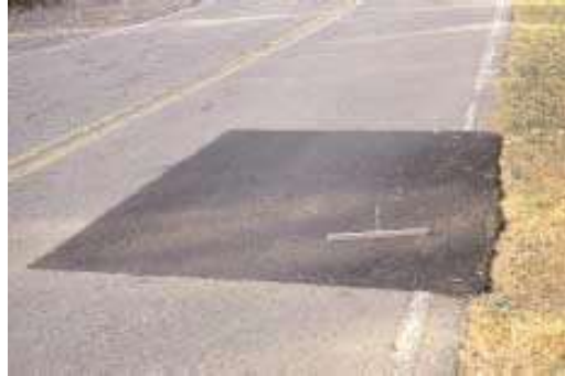
FIGURA 2.17: PARCHEO Y ZANJAS REPARADAS
