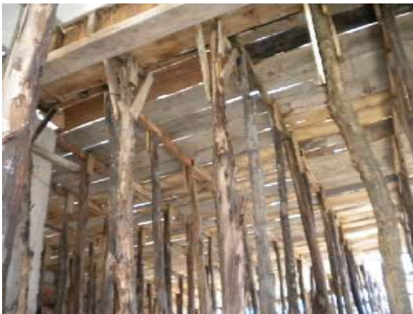
Figura # 37 – (Fotografía de un encofrado para losa reticular)
