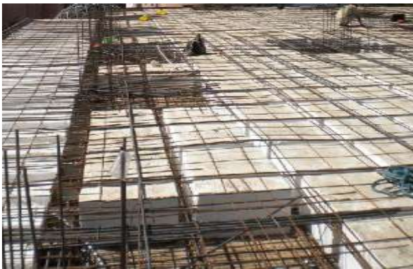
Figura # 41 – (Fotografía del colocado de la armadura para una losa reticular)
