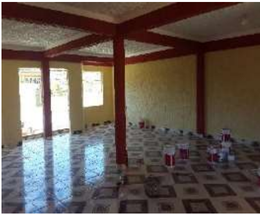
Figuras # 3 – 4 (Se observa las vigas sobresaliendo de la losa y la columna al centro del ambiente) Desde el punto de vista las losas reticulares permiten reducir la carga muerta por vigas de gran canto.
