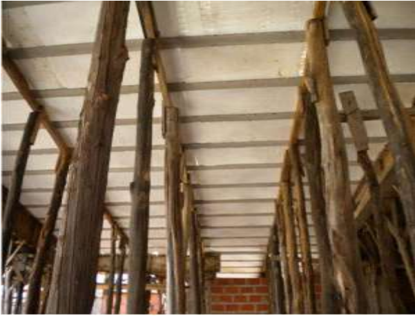
Figura # 48 – (Encofrado para una losa con viguetas pretensadas)
