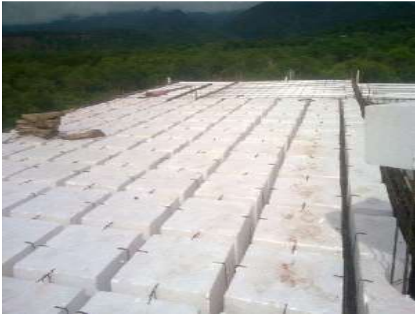
Figura # 38 – (Fotografía del colocado de los complementos para una losa reticular)
