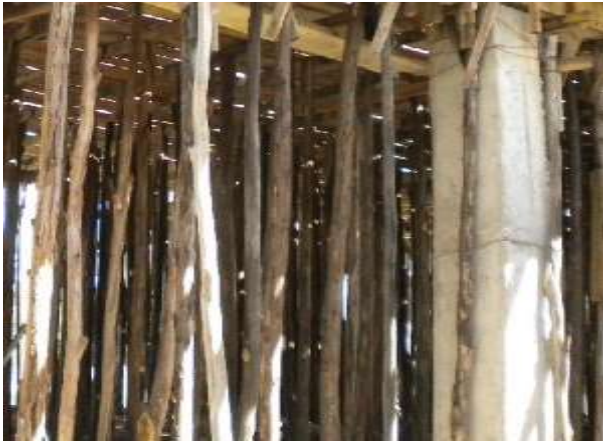
Figura # 36 – (Fotografía de un encofrado para losa reticular)
