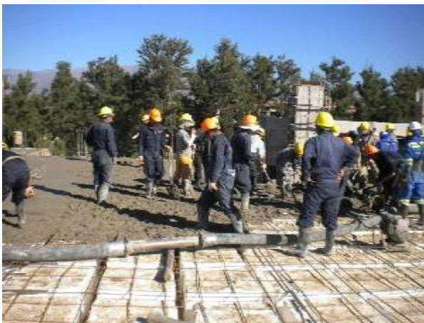
Figura # 44 – (Fotografía del proceso de hormigonado en losas reticulares)
