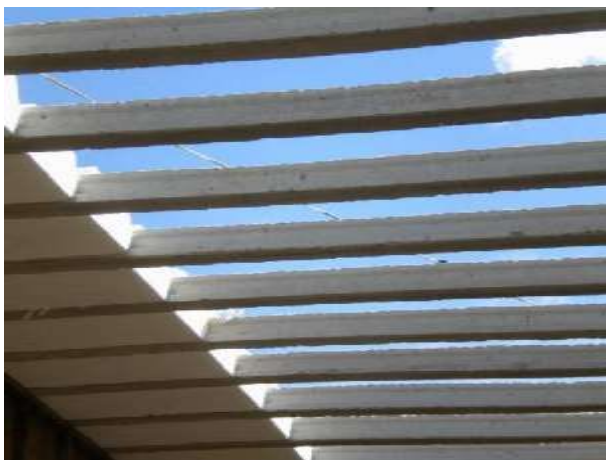
Figura # 47 – (colocado de viguetas pretensadas)
