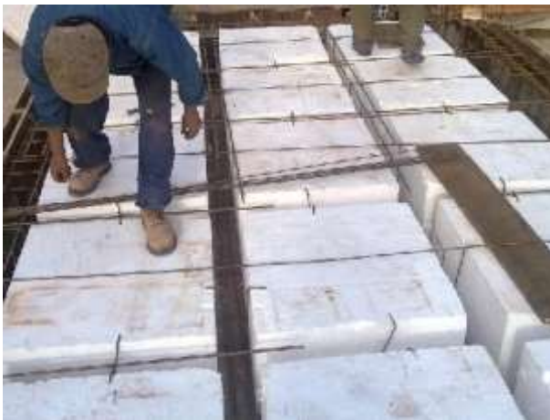
Figura # 39 – (Fotografía del colocado de los complementos para una losa reticular)
