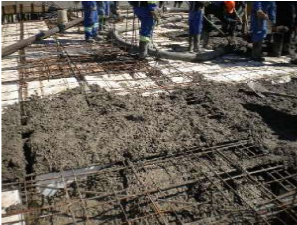
Figura # 45 – (Fotografía del proceso de hormigonado en losas reticulares)
