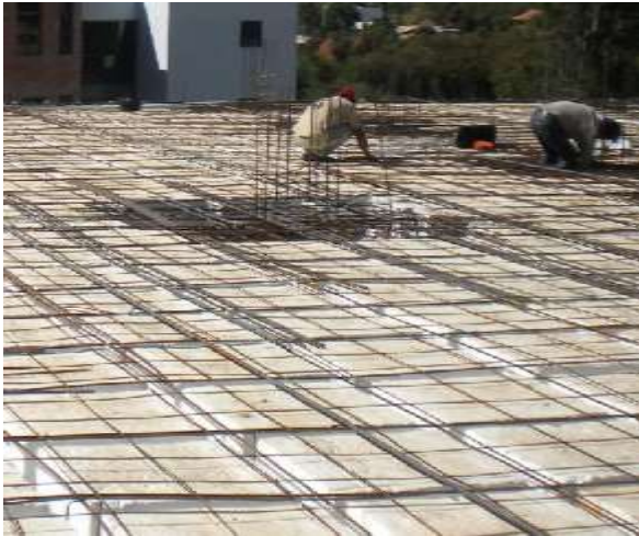
Figura # 40 – (Fotografía del colocado de la armadura para una losa reticular)
