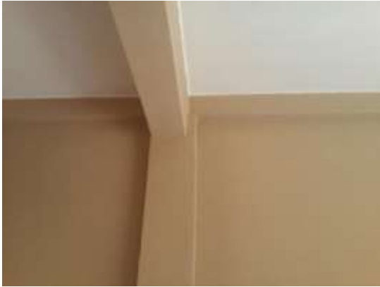
Figuras # 1 – 2 (Se observa las vigas sobresaliendo de la tabiquería)
