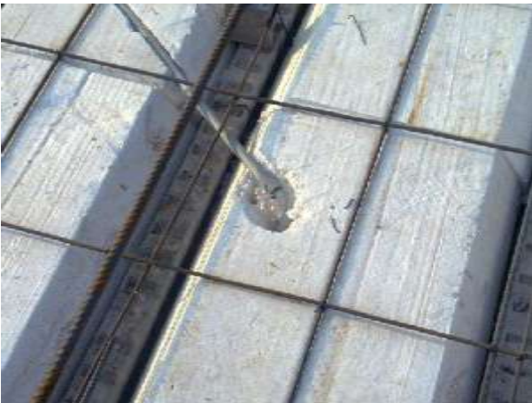
Figura # 49 – (Viguetas, complementos y armadura de refuerzo en la capa de compresión colocados)
