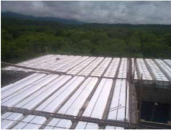
Figura # 50 – (Viguetas, complementos y armadura de refuerzo en la capa de compresión colocados)
