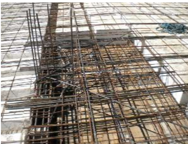
Figura # 42 – (Fotografía del armado de un ábaco)
