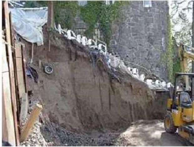
Figura 14: Sistema de apuntalamiento de suelo congelado instalado con dificultad sobre la ladera.
