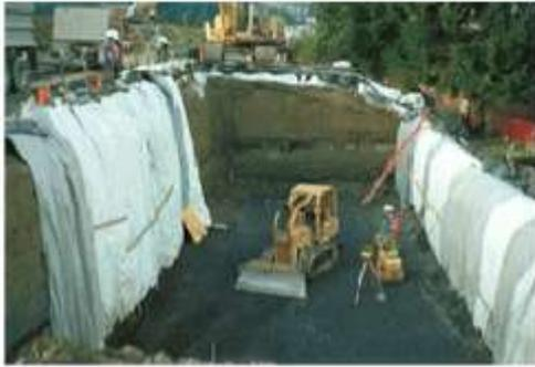
Figura 12: Excavación realizada en suelo congelado
