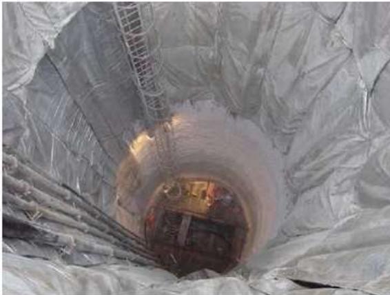
Figura 15: Vista superior del pozo congelado, con la exposición parcial de la pared
