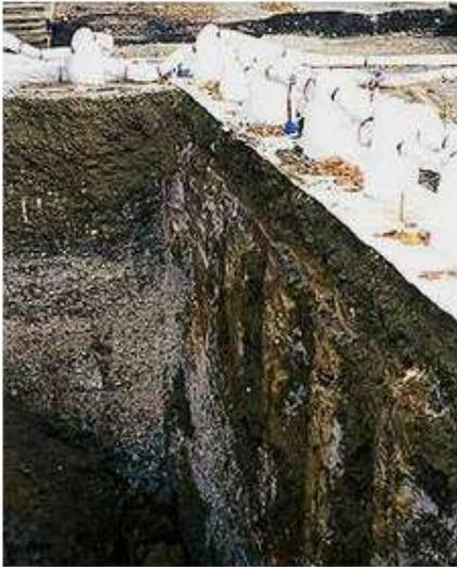
Figura 10: Suelo congelado de apuntalamiento de una excavación del subterráneo de un condominio en el Parque de Madiso
