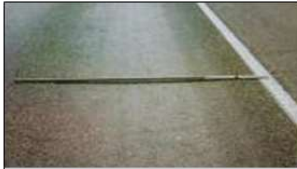
Figura 9. Ahuellamiento
