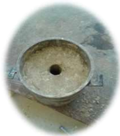
Figura 3.3 Perforación de Dren
