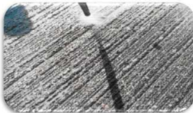
Figura 2.33: Faena de limpieza más profunda, usando aire comprimido, para remover las partículas más pequeñas.
