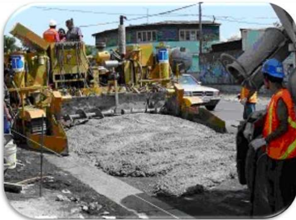
Figura 2.35: Tren pavimentador en faenas de hormigonado.
