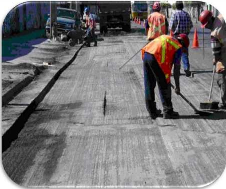
Figura.2.32: Faenas de limpieza con escobillón para las partículas grandes.
