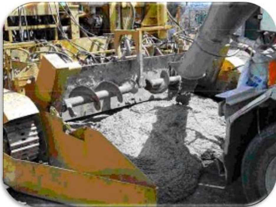
Figura 2.34: Colocación del hormigón, directamente desde el camión Mixer.
