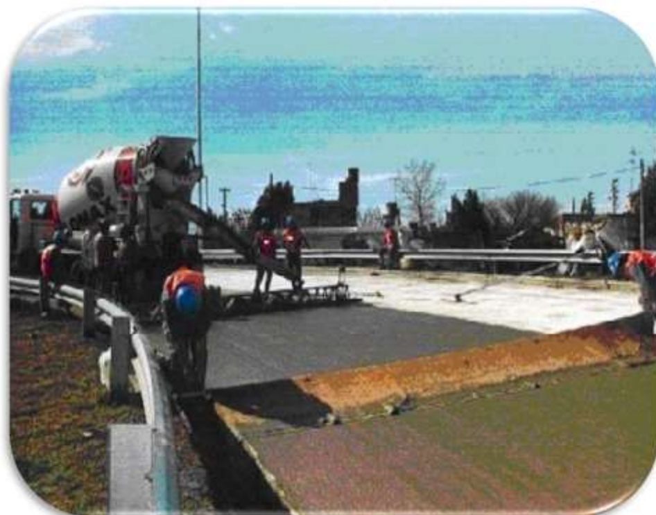
Figura 2.36: Aplicación de aspillera, para la obtención de la textura rugosa.
