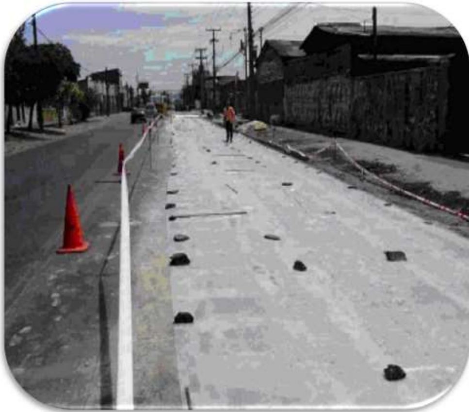
Figura 2.38: Aplicaciones de mantas de polietileno para el curado del hormigón.
