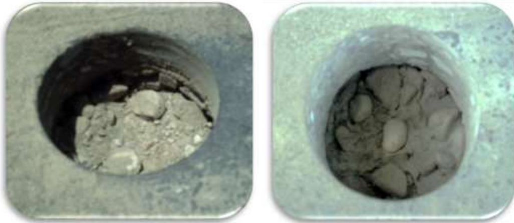
Figura 3.3: Capa base conformada por grava chancada y arena.
