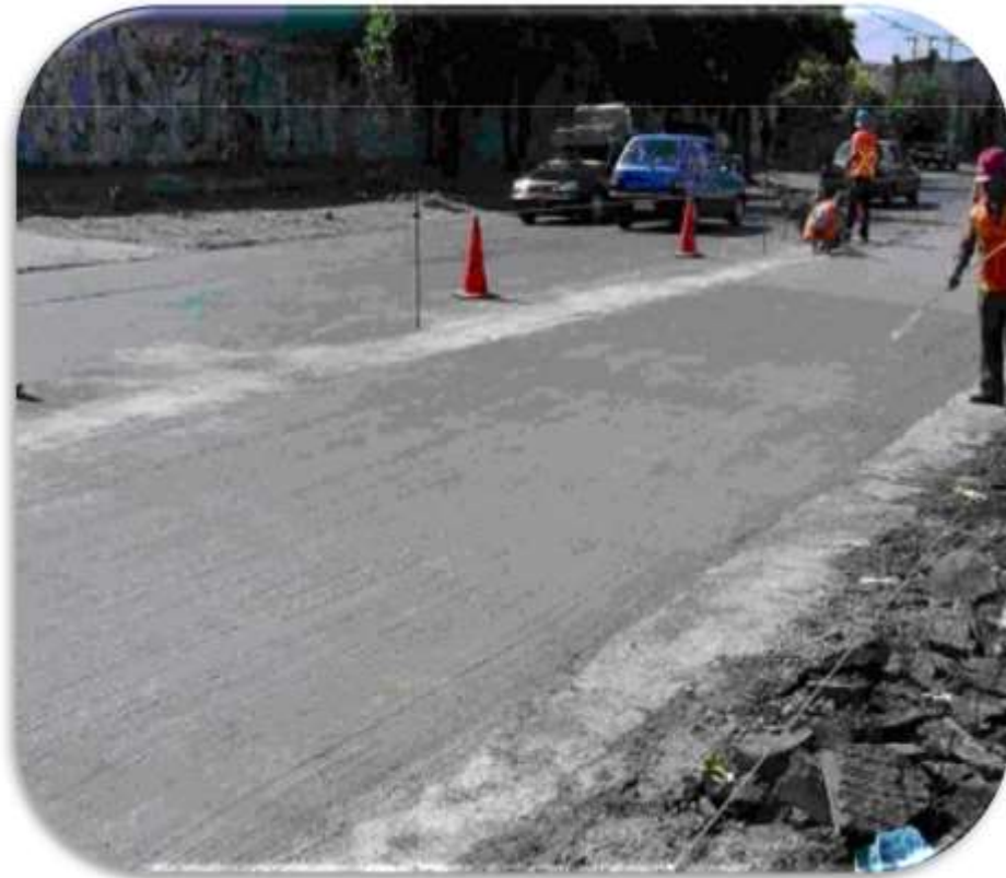
Figura 2.37: Aplicación de la membrana de curado.
