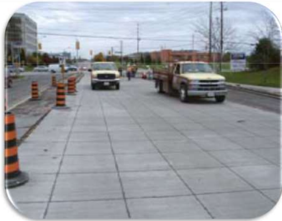
Figura 2.39: Apertura al tránsito.
