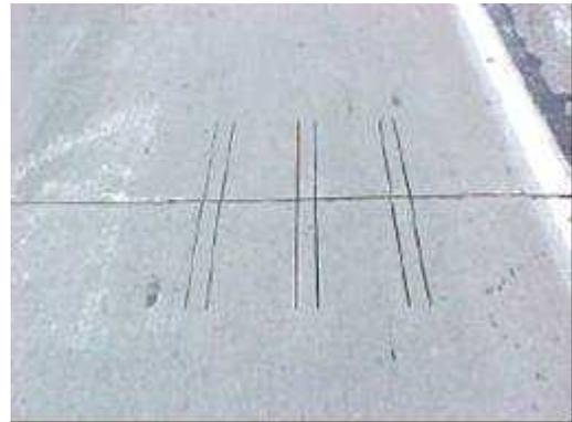
*Figuras 20. Corte de las ranuras para la inserción de barras de transferencia
