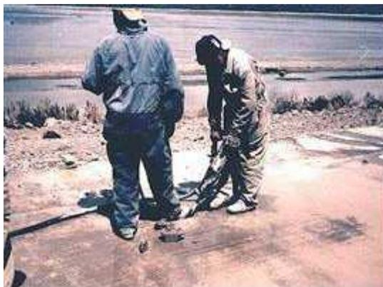
*Figura 21. Picado de las ranuras (Fuente: Proyecto Oruro – Toledo)*
