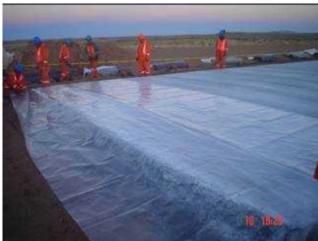
*Figura 38. Aplicación 1ª membrana de polietileno (Proyecto Ancaravi-Huachacla)*
