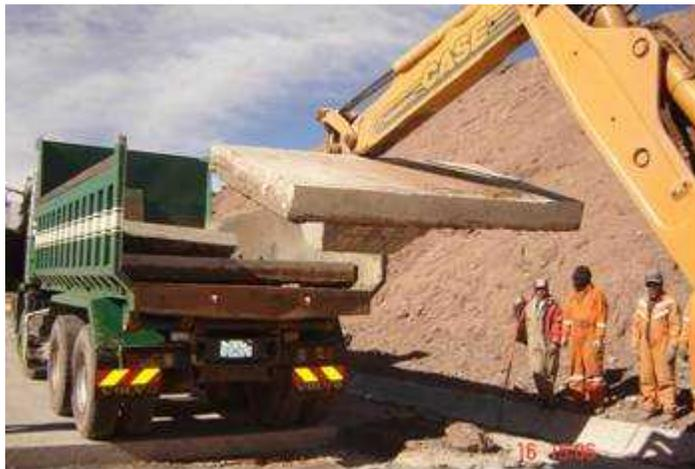
*Figura 63. Retiro mecanizado de los segmentos de losa.*
