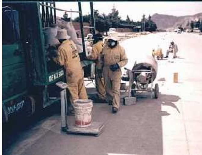
*Figura 28. Preparación del hormigón en obra.
