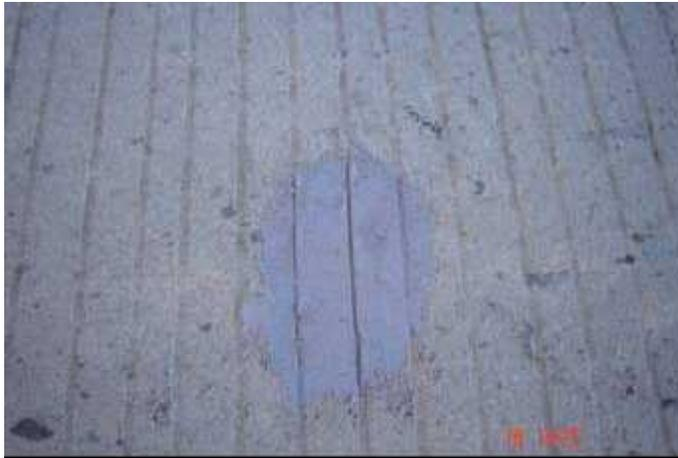
*Figura 51,52,53. Colocación de mortero epóxico, inserción de barra, terminado de orificio.*
