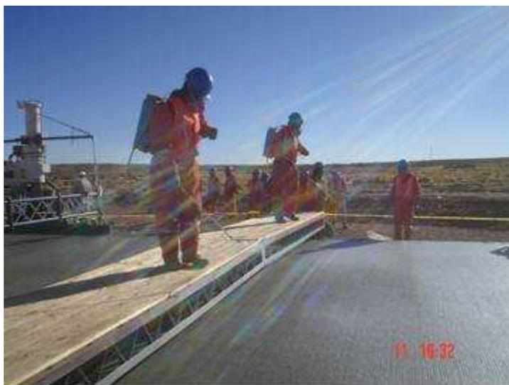
*Figura 37. Aplicación membrana de curado (Proyecto Ancaravi-Huachacla)*
