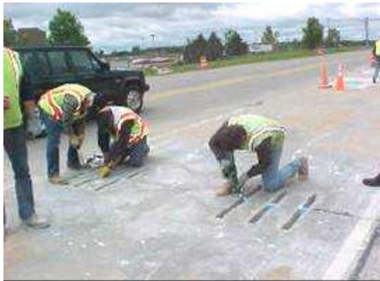
*Figuras 27. Colocación de las barras de transferencia de carga
