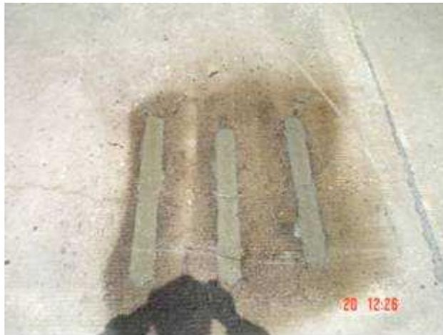
*Figura 32. Rellenado terminado y curado
