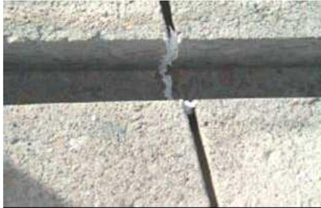
*Figura 24. Sellado de la fisura en la ranura*
