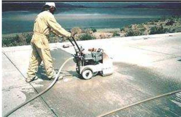
*Figura 59. Equipo para el desbaste de la superficie.*
