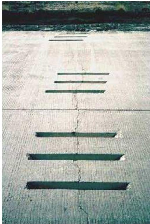
*Figura 23. Ranuras listas para el colocado de las barras de transferencia
