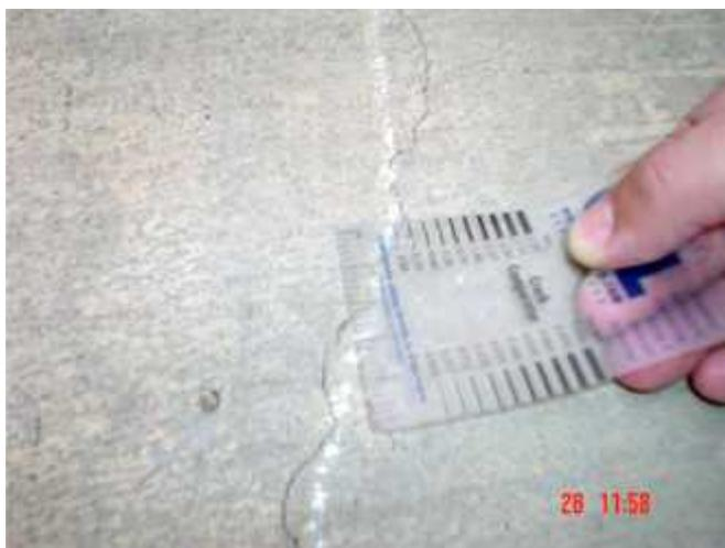
*Figura 7. Medición del ancho de las fisuras
