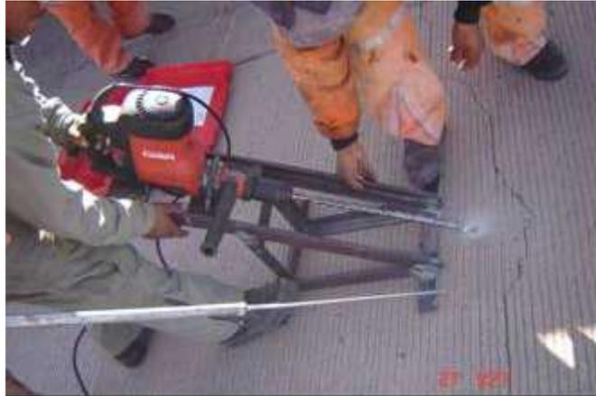
*Figura 47. Perforado de la losa de hormigón.*
