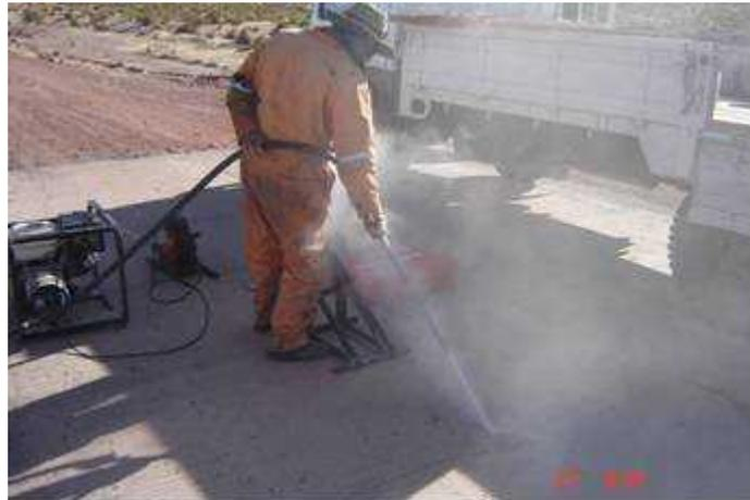
*Figura 48. Limpieza con aire a presión.*
