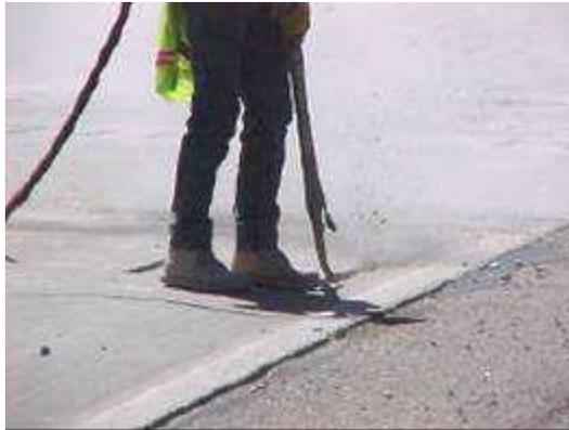
*Figuras 22. Limpieza de las ranuras con aire a presión
