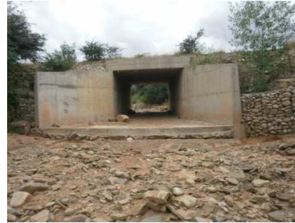
Cabezal con erosión apreciable.
