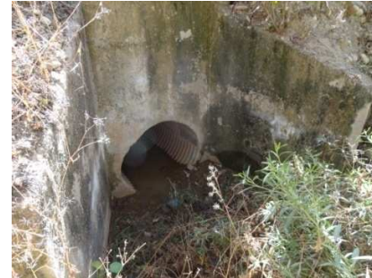
Cabezal aguas abajo, llena de maleza por falta de mantenimiento.
