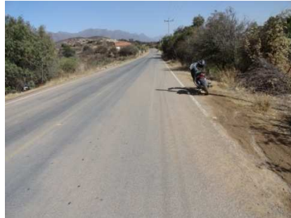
No se observan daños en la calzada.
