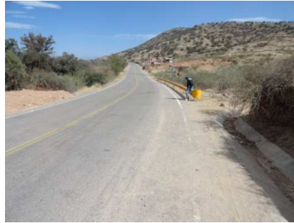
No se observan daños en la calzada.
