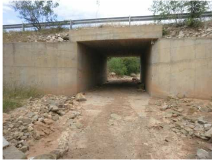
Cabezal aguas arriba limpio con suficiente sección.
