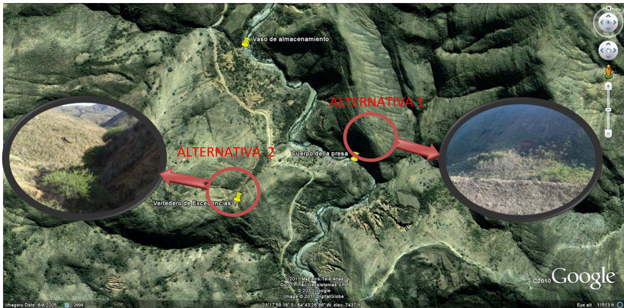
Figura 7.1 Sitios potenciales de emplazamiento del aliviadero
