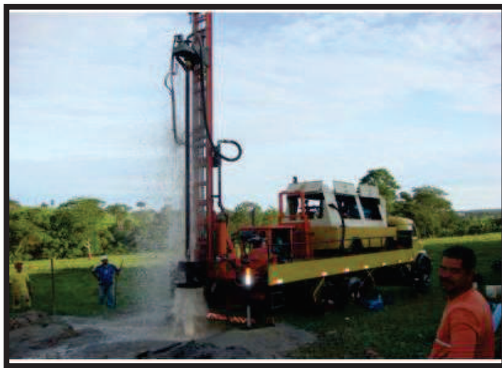
Figura 3.3. Maquinaria de perforación de pozos de agua
