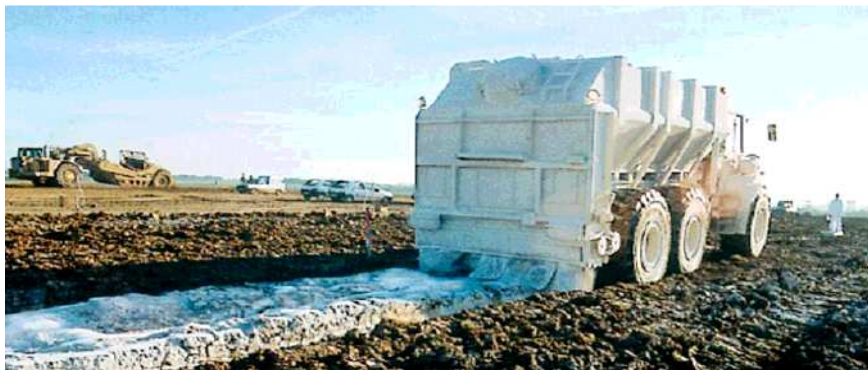
Fig. 3.10.- Extendido de la cal por vía seca.
