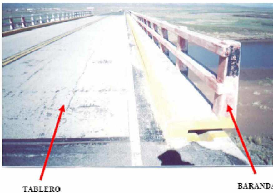
Figura 3.11. Puente con mantenimiento
