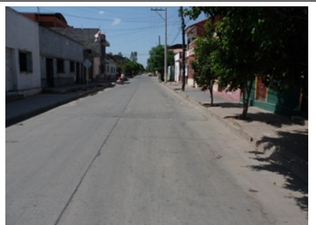
4.24. ROMPEMUELLES SIN SEÑALIZACIONES
