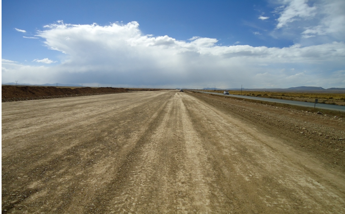
Figura 4.8. Capa Sub rasante de la carretera.
