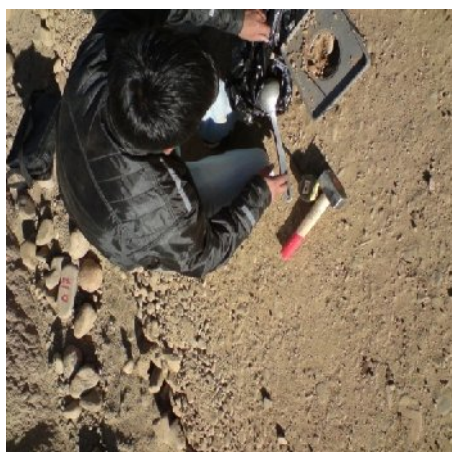
Figura 12. Colocación de la placa base
