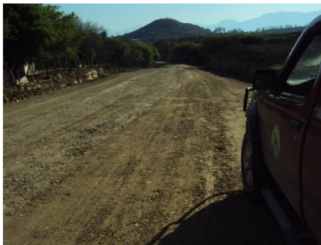
Figura 25. Fotografía del Tramo
