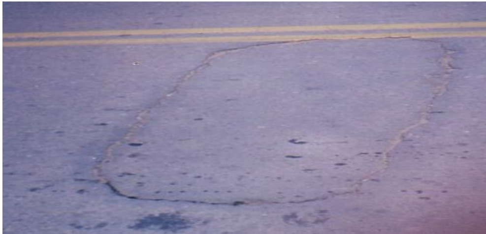
FIGURA 3.20. BACHEO Y ZANJAS REPARADAS
