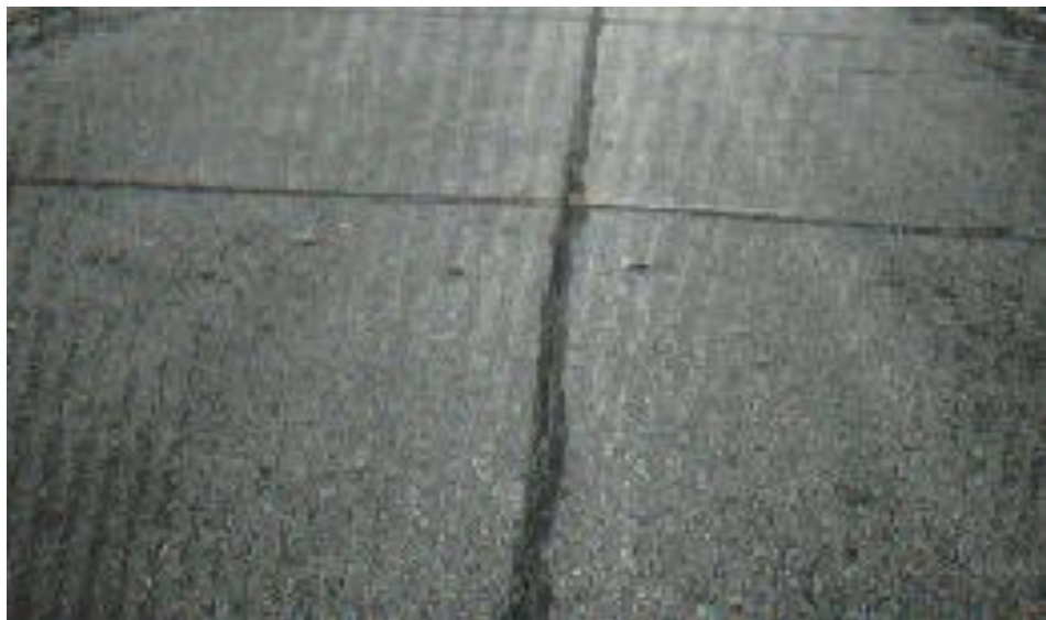
FIGURA 3.17. REFLEXION DE JUNTAS
