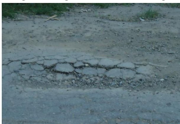
Fotografía 3.16 Deformación por Empuje Fuente: Elaboración Propia
