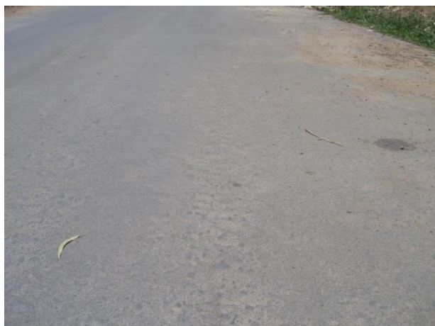
Fotografía 3.15 Ahuellamiento Fuente: Elaboración Propia
