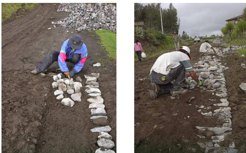
Fotografía 2.8 Colocación de Maestras o Cordones maestros Fuente: OIT
