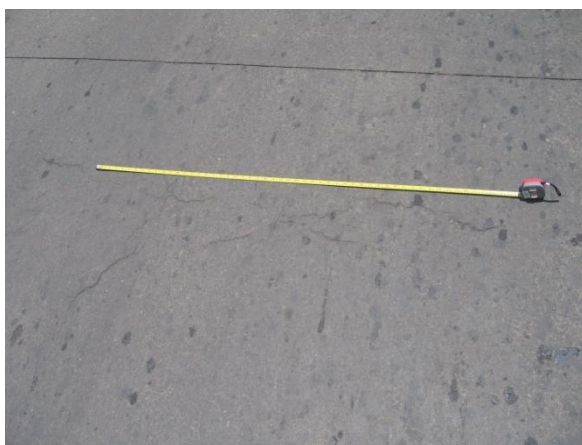
Fotografía 3.10 Grietas Transversales Fuente: Elaboración Propia
