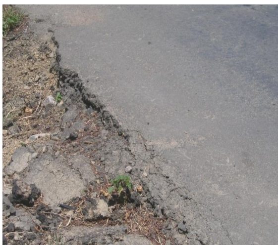
Fotografía 3.8 Desnivel Calzada-Berma Fuente: Elaboración Propia
