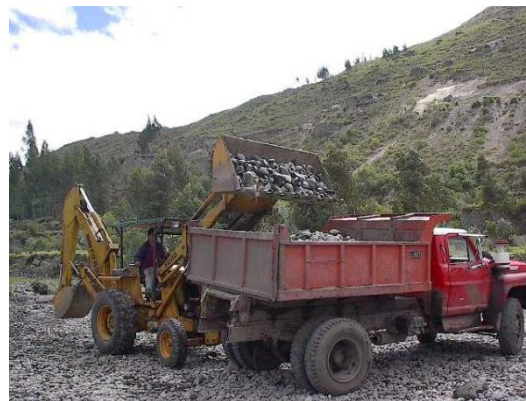
Fotografía 2.2 Carga de material a Volqueta Fuente: OIT
