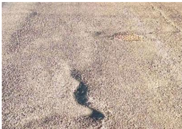
Fotografía 2.29 Deformación por Empuje Fuente: INVIAS Colombia
