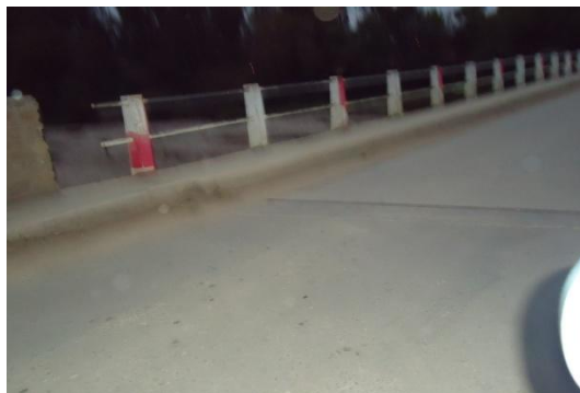
Fotografía 2.27 Acceso a puentes Fuente: INVIAS Colombia
