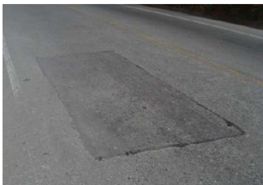
Fotografía 2.24 Bacheos y zanjas reparadas Fuente: INVIAS Colombia
