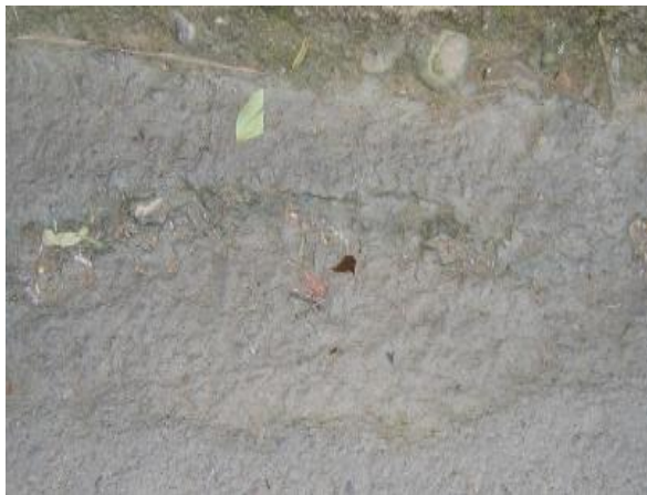
Fotografía 3.6 Depresiones Fuente: Elaboración Propia
