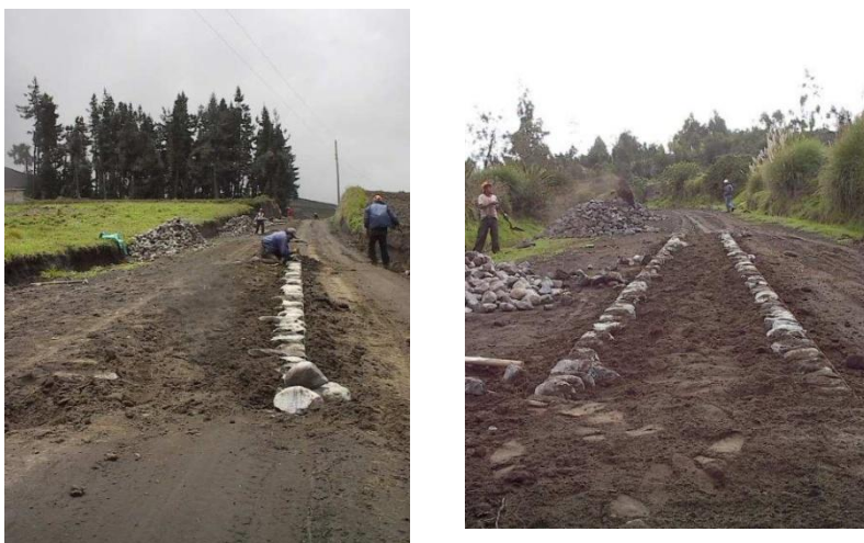
Fotografía 2.8 Colocación de Maestras o Cordones maestros Fuente: OIT
