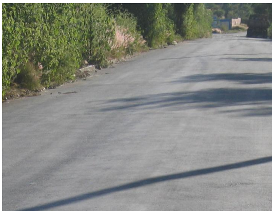
Fotografía 3.5 Corrugaciones Fuente: Elaboración Propia
