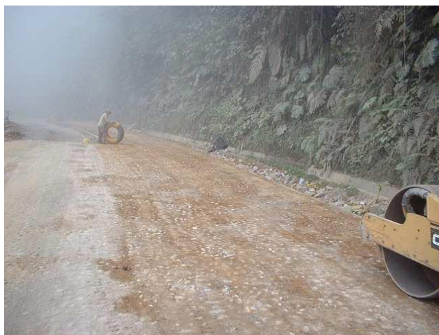
Fotografía 2.11 Rodillado del Emporado Fuente: OIT
