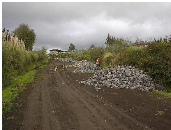
Fotografía 2.6 Transporte y Acopio de Material Fuente: OIT
