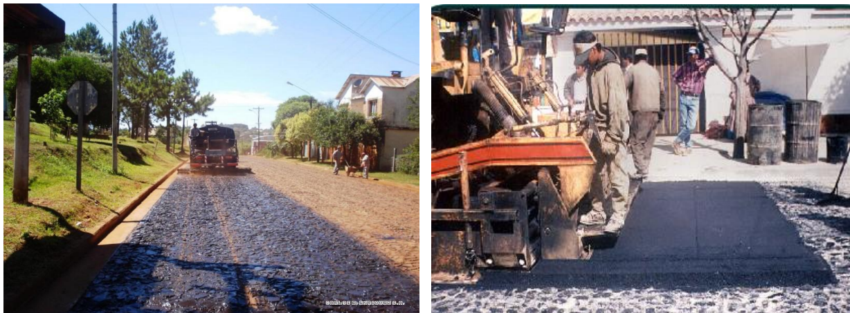
Fotografía 2.12 Imprimación Bituminosa y Colocado de la Carpeta Asfáltica sobre Empedrado Fuente: G.M. Tarija
