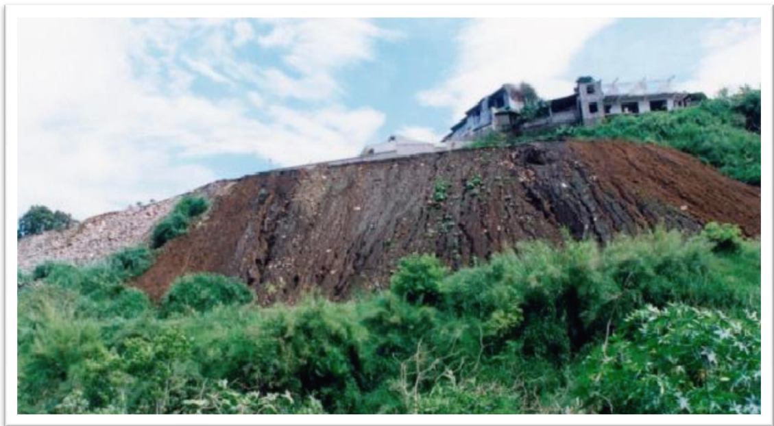
Foto 2: Deslizamiento producido por la saturación del suelo. Además puede observarse la inclinación de los árboles respecto de la vertical, lo que hace pensar que se está ante la presencia de creep.
