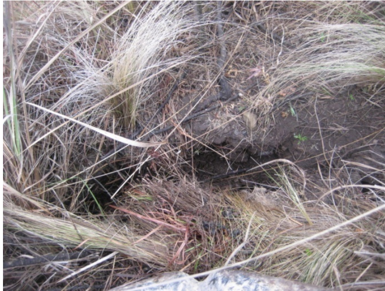
Fotografía 4.41. Cárcavas de Erosión Talud “C”
