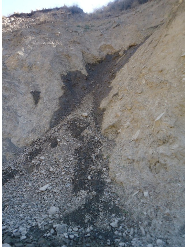
Fotografía 4.47. Presencia de agua Talud “D” (ojos de agua).
