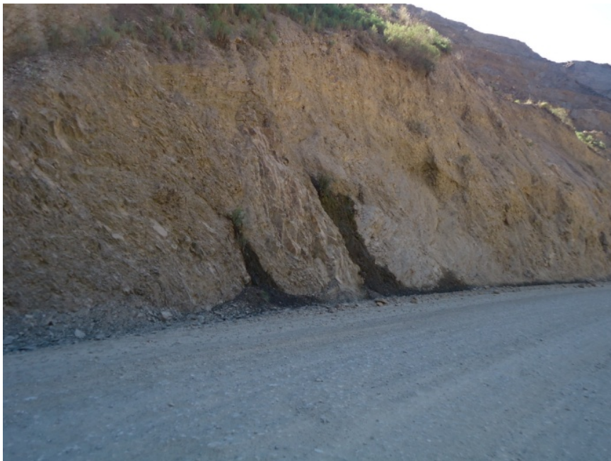
Fotografía 4.46. Presencia de agua Talud “D” (ojos de agua).
