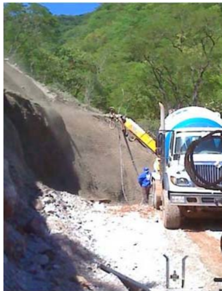
Fotografía 2.7. Camión con Bomba lanzando Hormigón.
