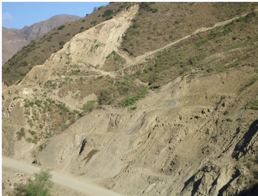
Fotografía 4.5. Vista del Talud “C” y del Talud “D”
