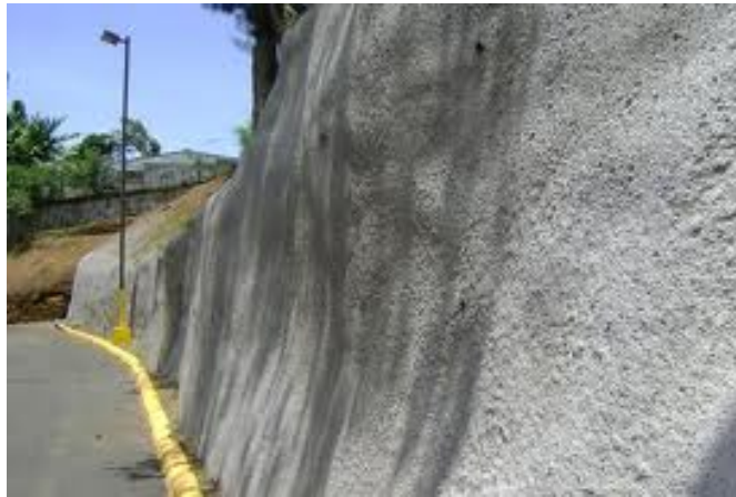
Fotografía 2.6. Hormigón Lanzado.
