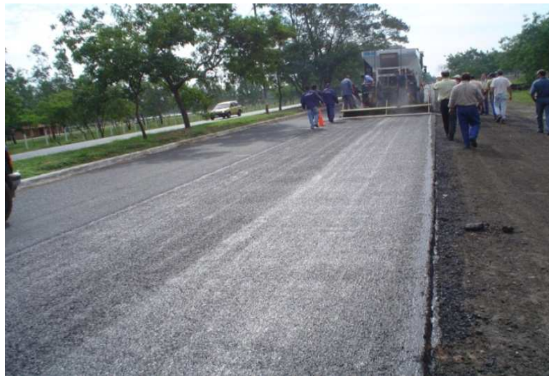
Figura 2.33 Construcción de nuevo pavimento
