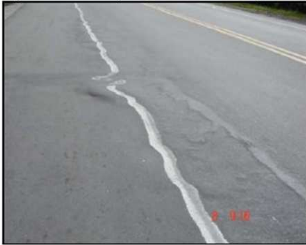
Figura 2.12. Corrugación (Unidad de medida: m2)
