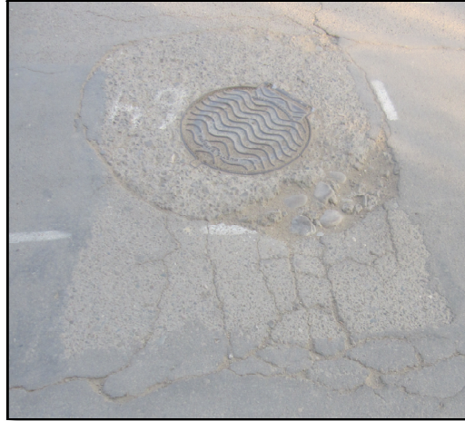
Figura 2.22. Tapas de alcantarillado (Unidad de medida: m2)
