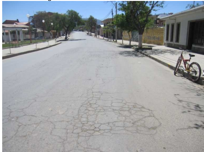
Figura 3.2 Inicio del tramo en estudio
