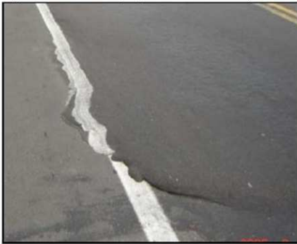
Figura 2.10. Abultamiento (Unidad de medida: m2)
