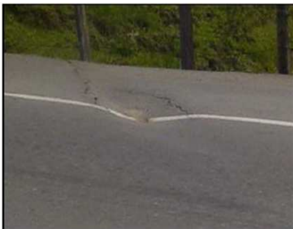
Figura 2.11 Hundimiento (HUN, Unidad de medida: m2)
