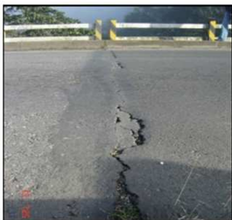
Figura 2.5 Fisuras por reflexión de juntas en placas de concreto (FJL o FJT, Unidad de medida: m)
