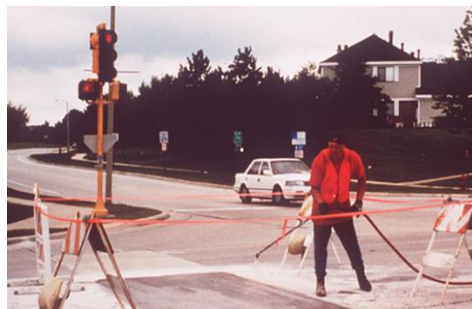
Foto 4.11 Curado con compuesto pigmentado
