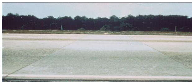
Foto 4.12 Reparación de pavimentos de losas de concreto en espesor total terminada.
