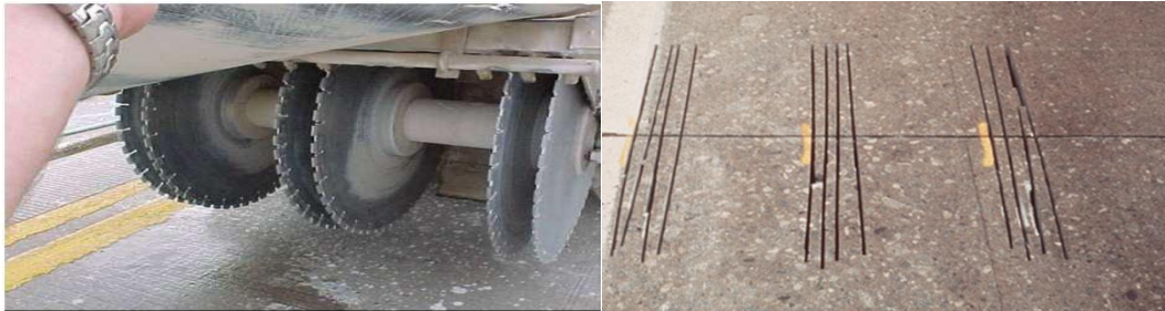
Foto 4.30 Cortado del pavimento mediante cortadoras estandar (Fuente: Curso de restauracion de pavimentos rigidos del IBCH)
