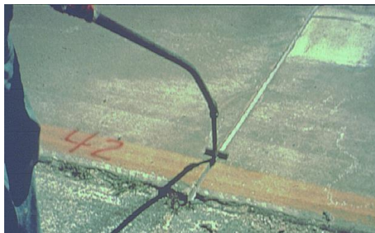
Foto 4.23 Sellado de la junta despues de una Reparacion de profundidad parcial
