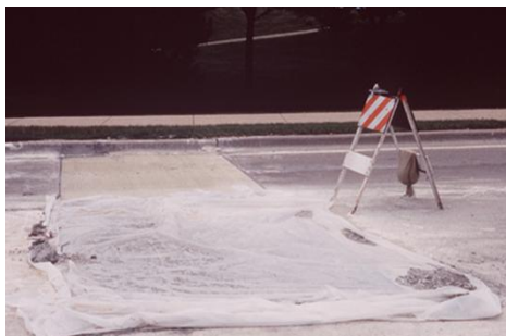
Foto 4.10 Curado con cubiertas de asilamiento
