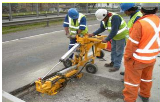
Foto 4.4 Perforaciones para dovelas mediante taladros montados en grupo
