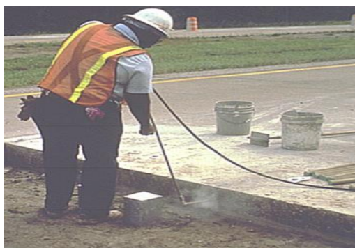
Foto 4.5 Limpieza de agujeros con aire comprimido (Fuente: Curso de restauracion de pavimentos rigidos del IBCH)
