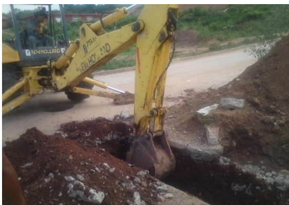
Extracción de material blando
