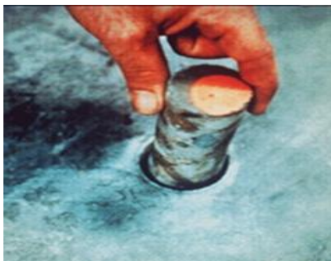
Foto 4.36 Perforación para inyección
