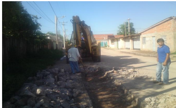
Foto 5.7 Limpieza del área demolida dejándola libre de materiales sueltos.
