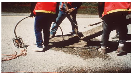
Foto 4.33 Vaciado del concreto en la barras
