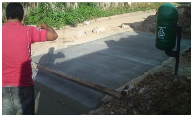
Foto 5.14 Losa restituida terminada y lista para abrir al tráfico
