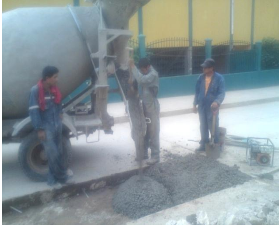
Foto 5.11 Colocado del concreto directamente de la hormigonera (Fuente: Elaboración Propia)
