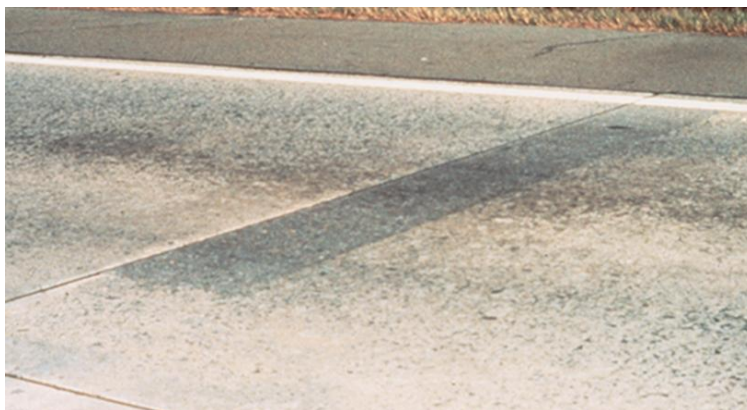
Foto 4.24 Reparacion de espesor parcial terminado y abierto al trafico
