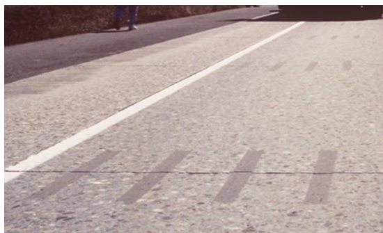
Foto 4.34 Retrocolocadode barras pasajuntas concluido
