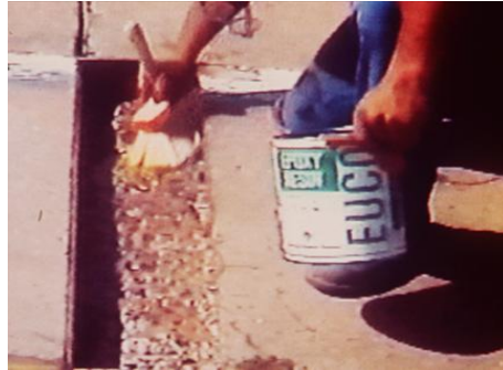
Foto 4.21 Colocacion del adherente
