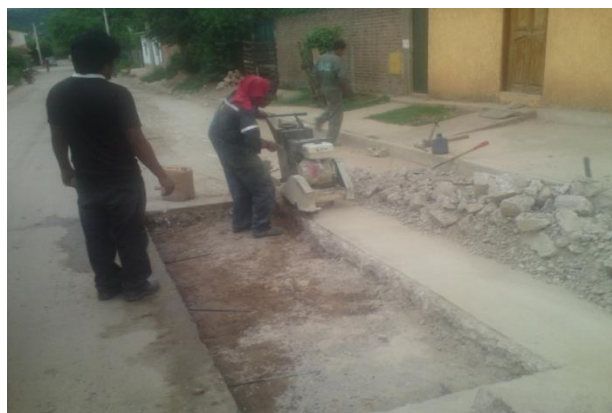
Foto 5.9 Reposición de las barras de amarre
