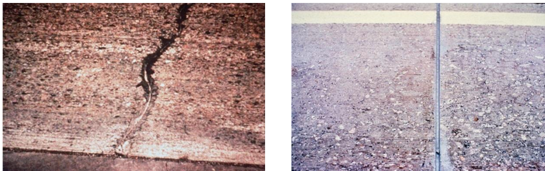
Foto 4.28 resellado de grietas y juntas terminado
