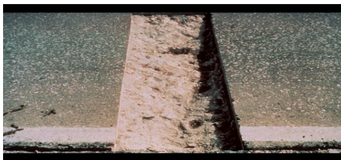
Foto 4.19 Trabajo preliminar completo y parche listo para la colocacion y acabado
