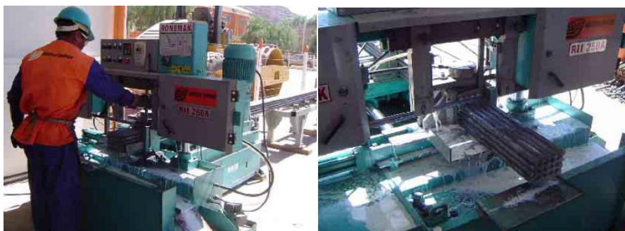
Foto 4.29 Equipo de cortado de barras
