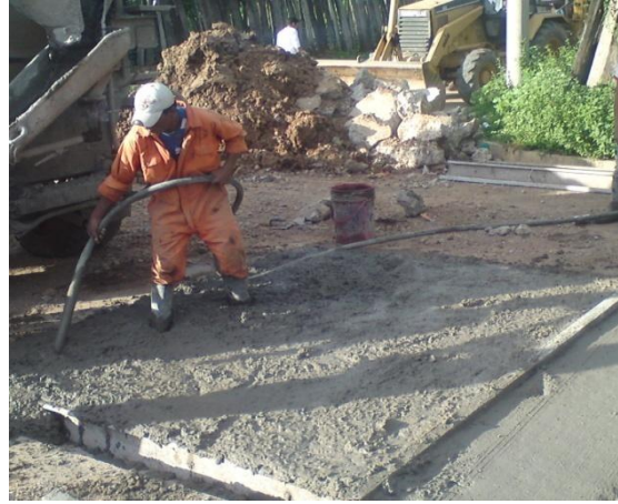
Foto 5.12 Vibrado y enrasado (Fuente: Elaboración Propia)
