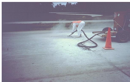
Foto 4.18 Limpieza con chorro de arena a presion
