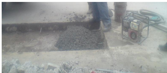
Foto 5.10 Verificación de dovelas en las vías de alto tráfico (av. a Yacuiba y av. a Tarija) (Fuente: Elaboración Propia)
