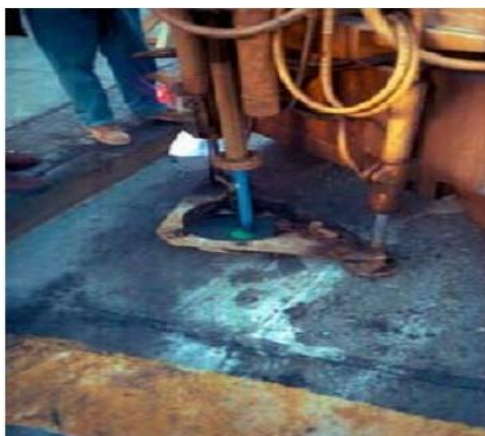
Foto 4.37 Proceso de inyección de la lechada
