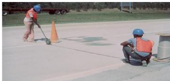
Foto 4.27 Instalación de tira de respaldo en juntas
