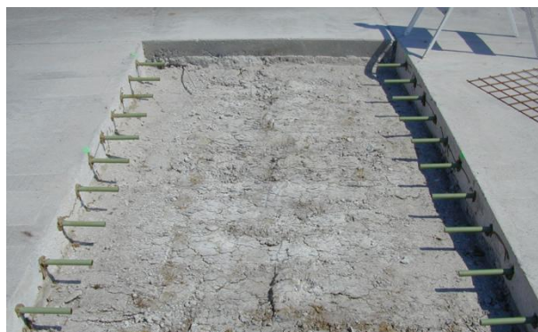
Foto 4.6 Area sujeta a reparacion una vez reposicionadas las dovelas
