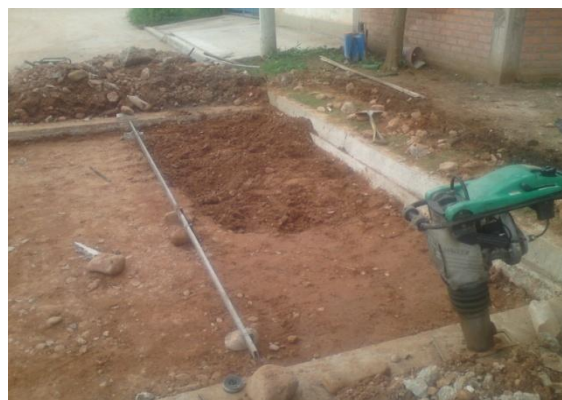
Recompactado de la base
