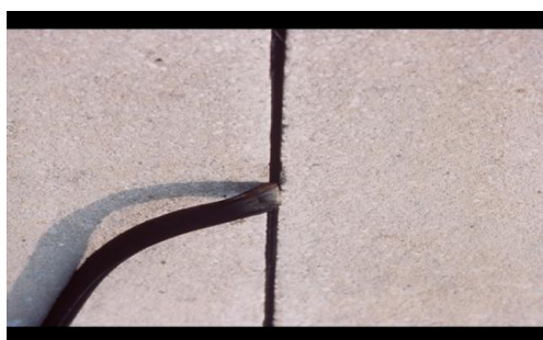
Foto 4.25 Extracción del sello antiguo en forma manual
