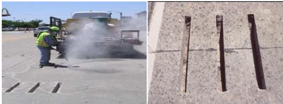
Foto 4.32 Limpieza de los depositos
