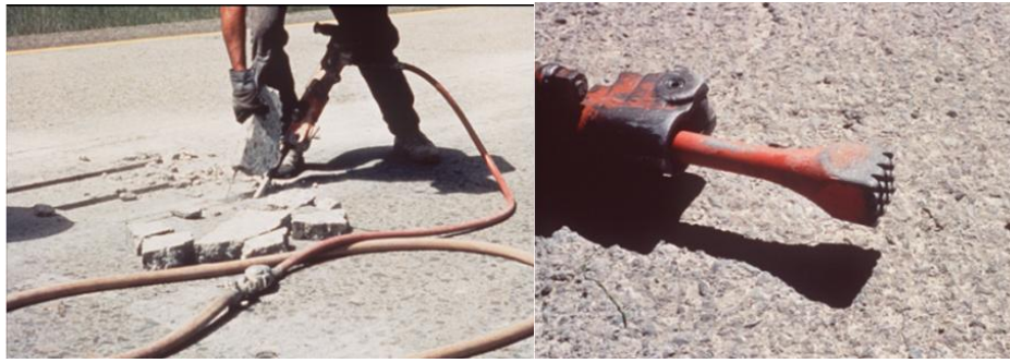
Foto 4.31 Preparacion de depositos
