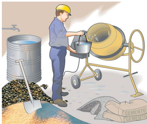
Figura 2.1 Mezclado de los componentes del concreto.
