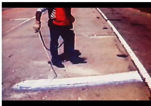
Foto 4.22 Curado luego de evaporado el agua de exudación (Fuente: Curso de restauración de pavimentos rígidos del IBCH)
