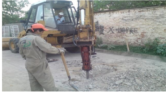
Foto 5.5 Demolición de losas con martillo hidráulico.
