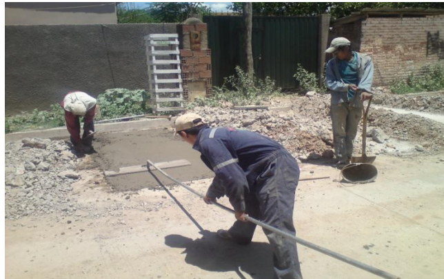
Foto 5.13 Texturizado del conereo mediante cepillo texturizador (Fuente: Elaboración Propia)
