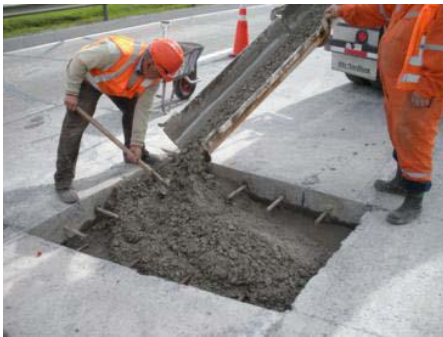
Foto 4.8 Vaciado desde vehiculo de transporte y distribucion Mediante paleo
