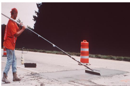
Foto 4.7 Texturizado, acabado similar al del pavimento existente
