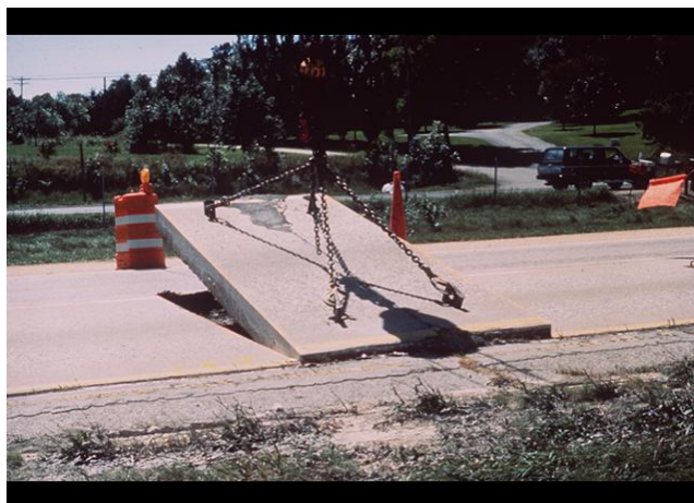
Foto 4.2 Remocion por izado
