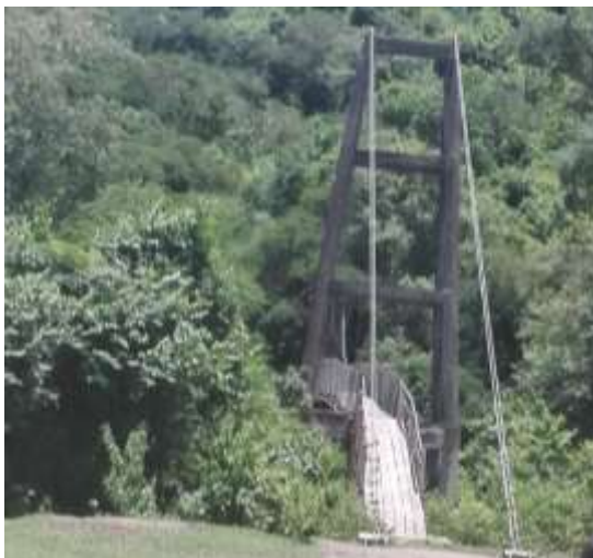
Fotografía N° 23 Puente Motovi (Comunidad de Motovi)
