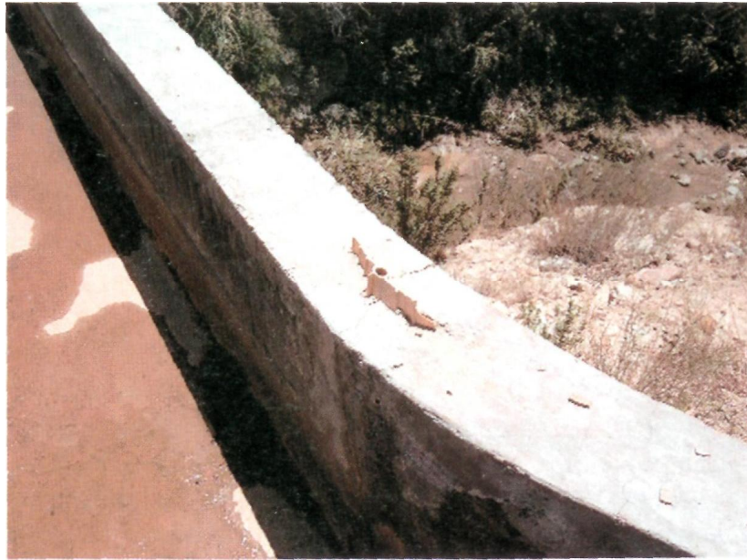
Figura 3 Cinta waterstop entre canal y acueducto
