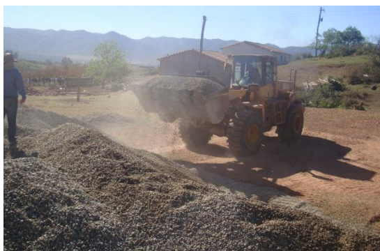
Cargado Del Árido En El Distribuidor De Agregados
