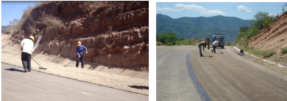
Fig. 4.33 ESPARCIMIENTO DEL LIGANTE Y EL ARIDO MANUALMENTE
