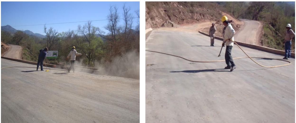
Barrido, Lavado y Soplado De La Superficie
