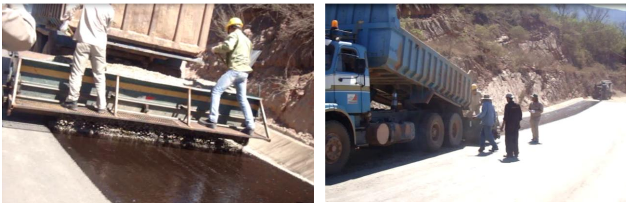
Fig. 4.28 ESPARCIDO DEL AGREGADO
