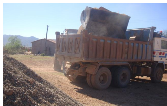
Cargado Del Árido En El Distribuidor De Agregados
