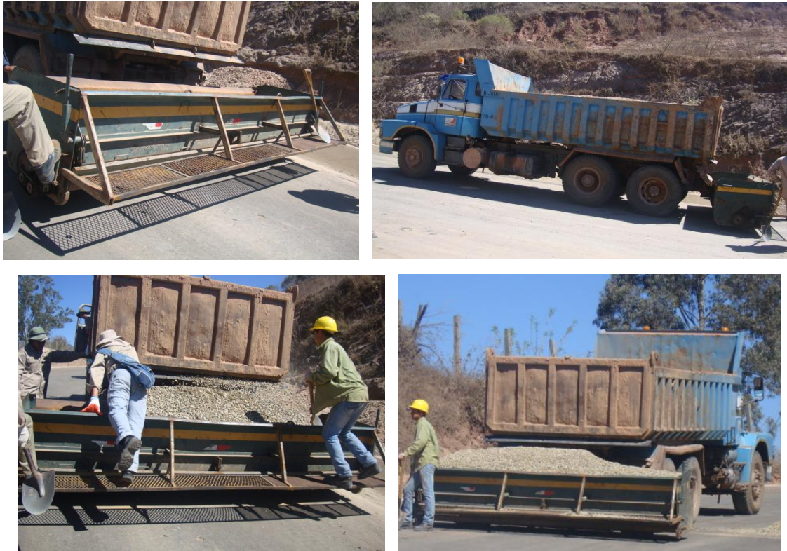
Fig. 4.27 CONTROL DE LA CAJA ADOSADA AL CAMIÓN DE AGREGADOS
