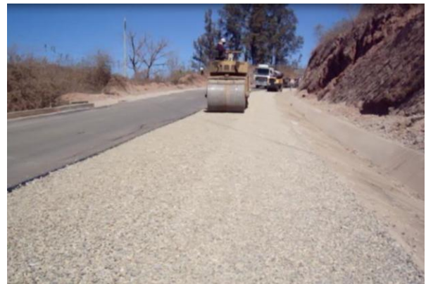
Fig. 4.30 COMPACTACIÓN DE LA SUPERFICIE
