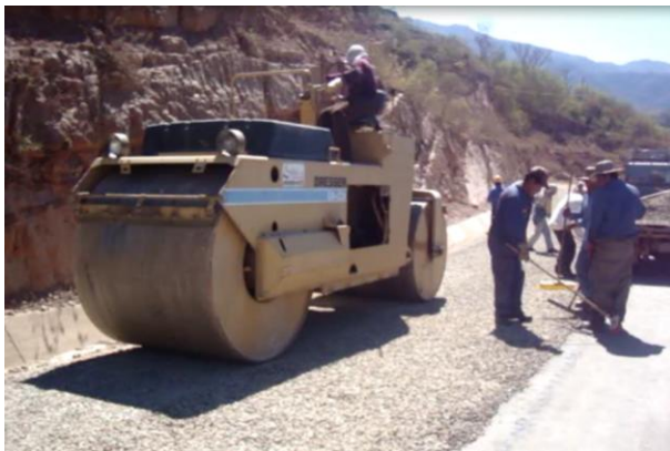
Fig. 4.30 COMPACTACIÓN DE LA SUPERFICIE
