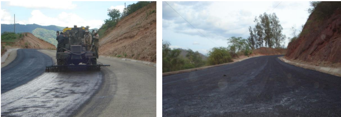
Fig. 4.31 EJECUCIÓN DEL BAÑO DILUIDO
