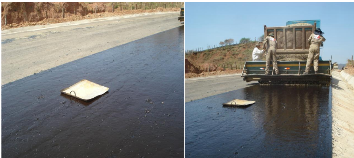
Fig.4.34 CONTROL DE LA TASA DE AGREGADO EN OBRA
