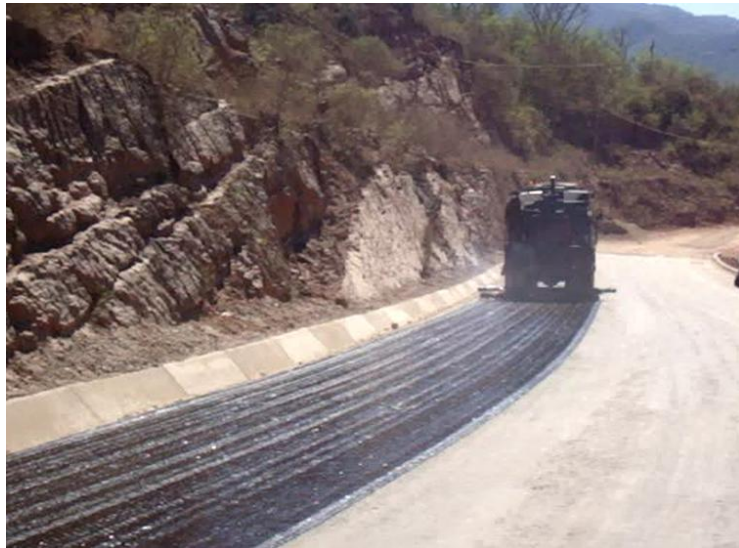
Fig.4.20 IMPRIMACIÓN DE LA BASE
