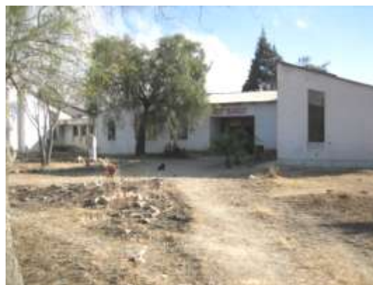
Figura. 3.2: Vista panorámica del lugar de emplazamiento.
