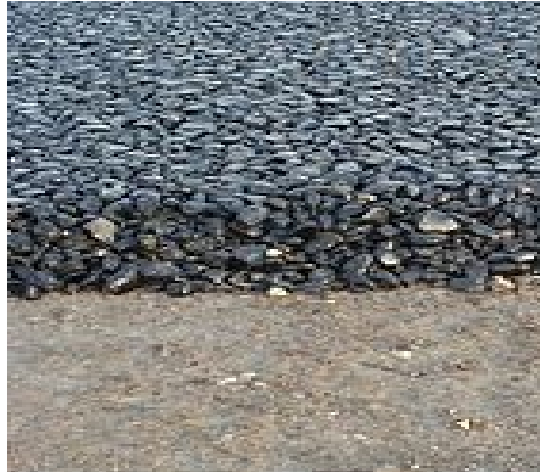
Fig. 3.9. Mezcla asfáltica compactada.
