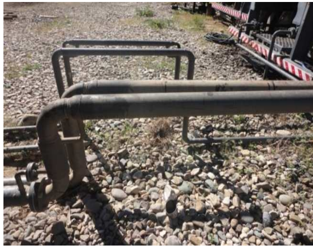
Fig. 3.5. Tuberías Encamisadas
