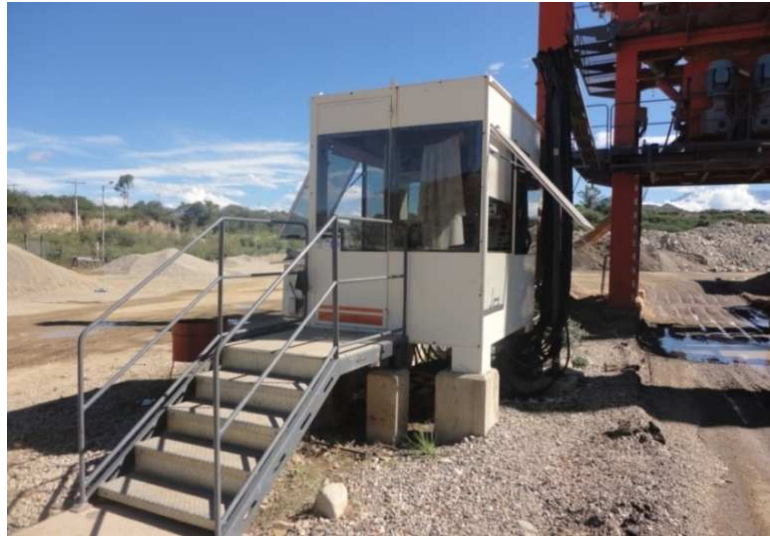
Fig. 3.8. Caseta de Control
