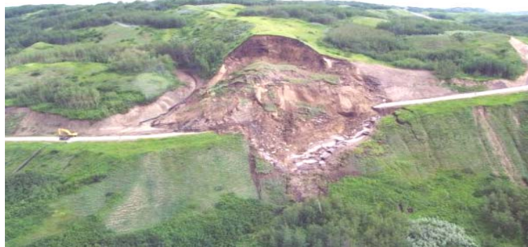
Foto 1. Ejemplo de deslizamiento rotacional circular
