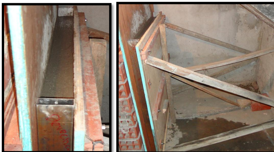
Paso N° 5.20. Placa vaciada o terminado. Fuente Propia
