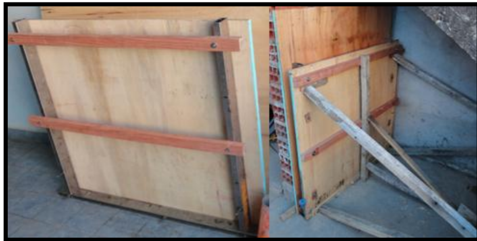
Fig. N° 5.14. Encofrado Fuente Propia
