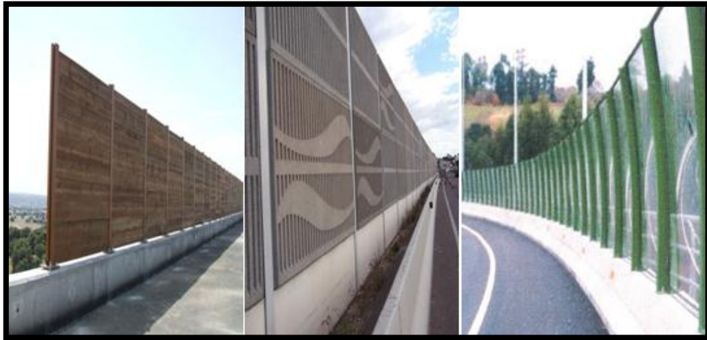
Figura N° 2.10. Distintos tipos de pantallas acústicas
