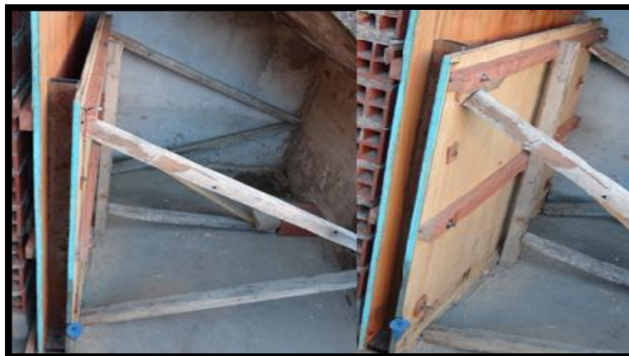
Figura N° 5.15. Encofrado. In situ. Fuente propia.
