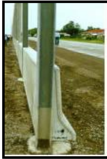
Figura 4.14 Poste Metálico Empotrado
