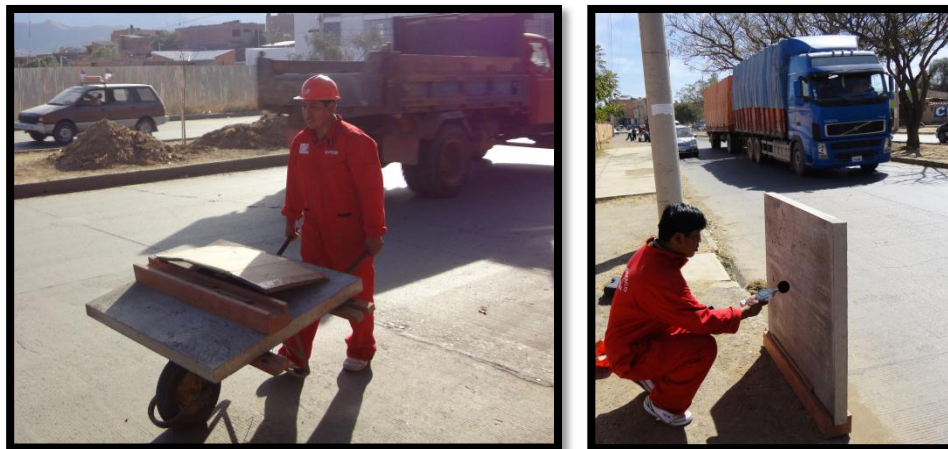
Figura N° 5.24. Montaje de las Placas Antirruído. Fuente propia.
