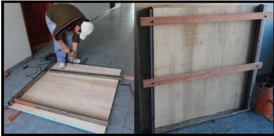
Figura N°5.13 Preparación del molde Fuente Propia
