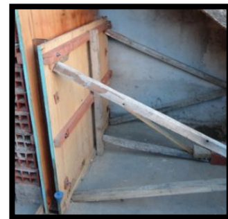
Figura N° 5.11. Encofrado. Fuente propia
