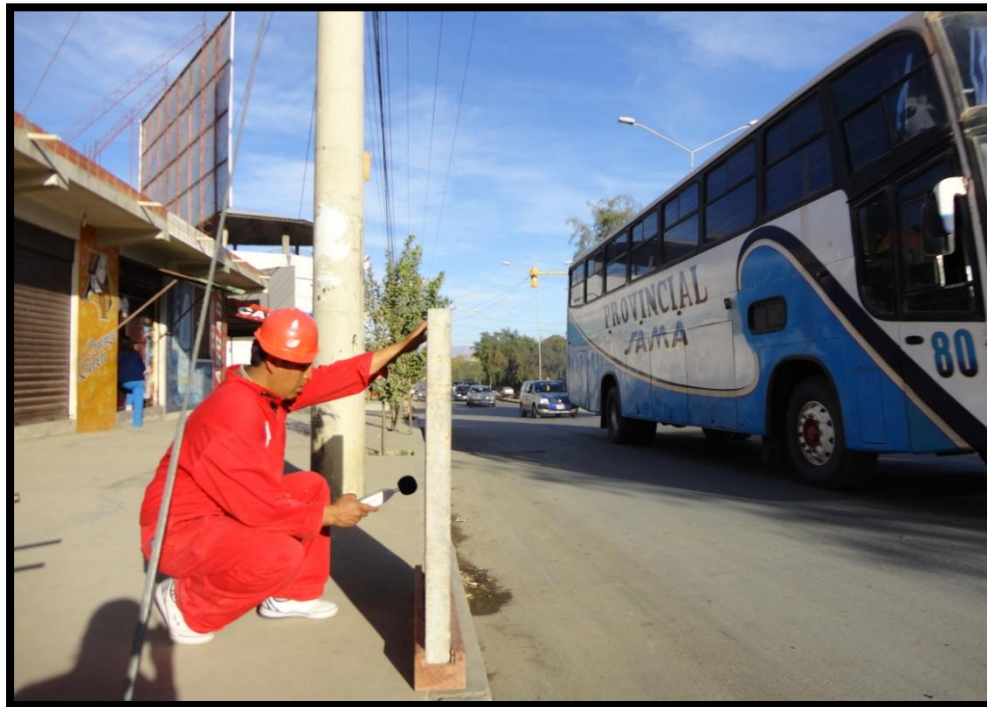
Figura N° 5.35. Esquina La Paz y Circunvalación subida norte. Fuente propia
