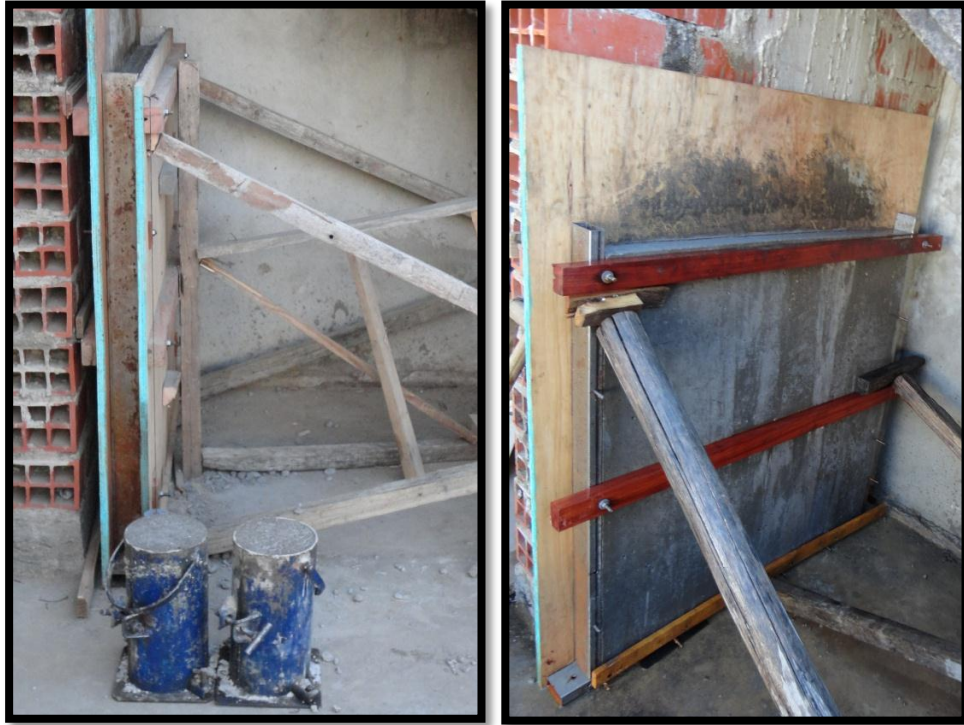
Figura N° 5.21. Desencofrado. Fuente propia
