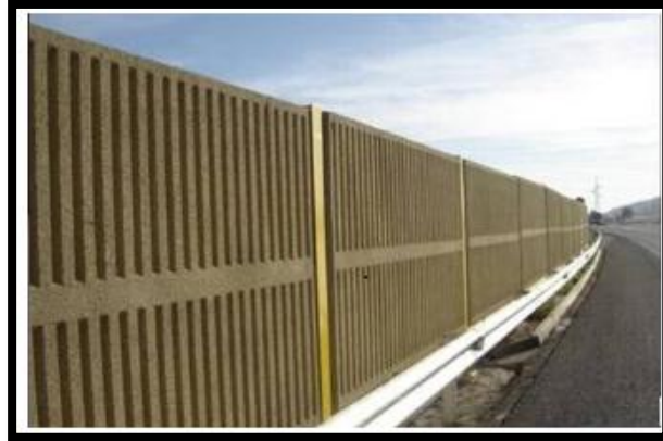
Figura 4.9 Pantallas prefabricadas de hormigón ligero
