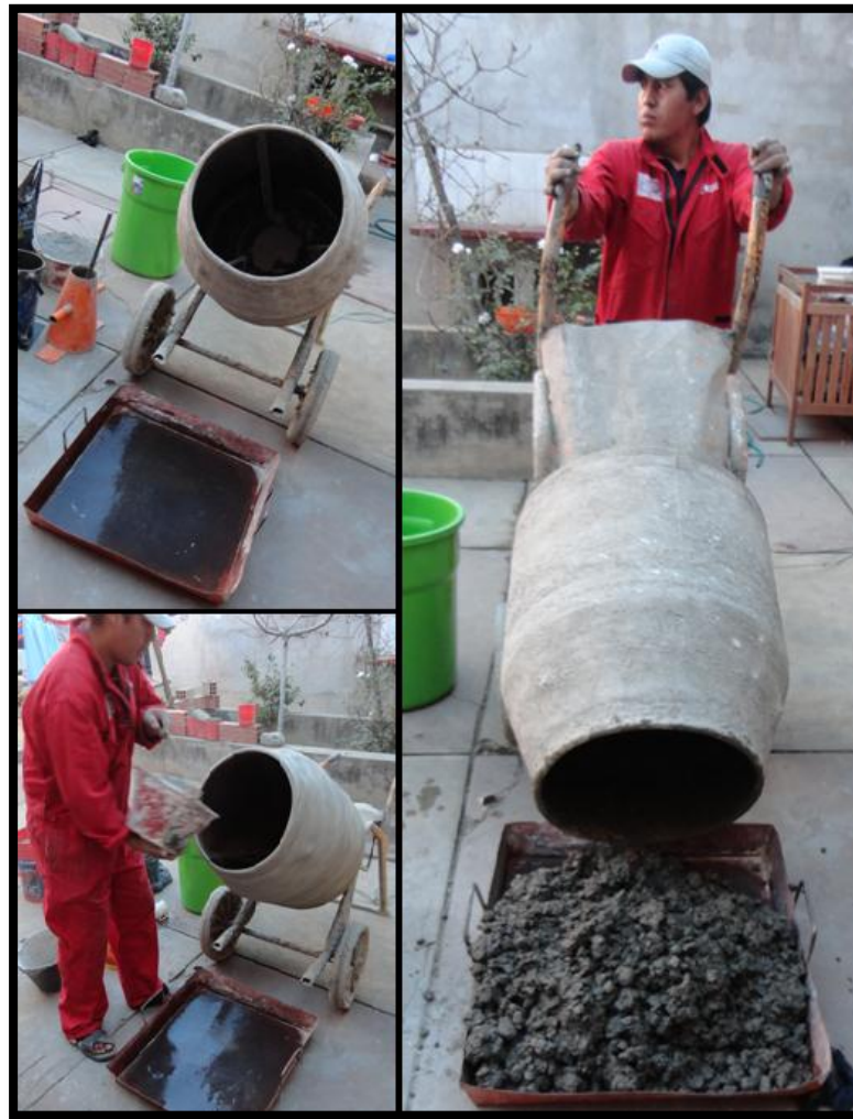
Paso N°5.17. Preparación vaciado del hormigón ligero, revenimiento. Fuente propia
