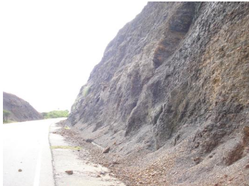
Fotografía 5.4 Píe de Talud
