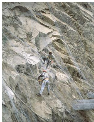
Fotografía 3.5 Estabilización con mallas
