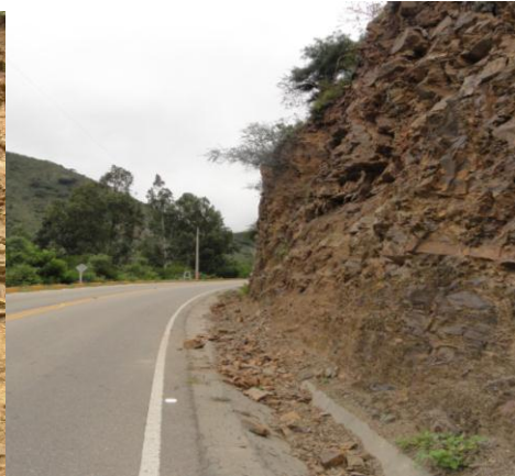
Fotografía 5.9 Pie de talud
