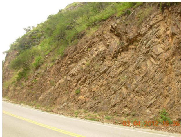
Fotografía 5.10 Buzamiento Talud N°3
