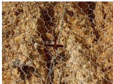
Fotografía 3.6 Colocación de Anclas en “T “
