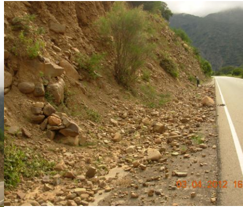
Fotografía 5.7 Píe de Talud
