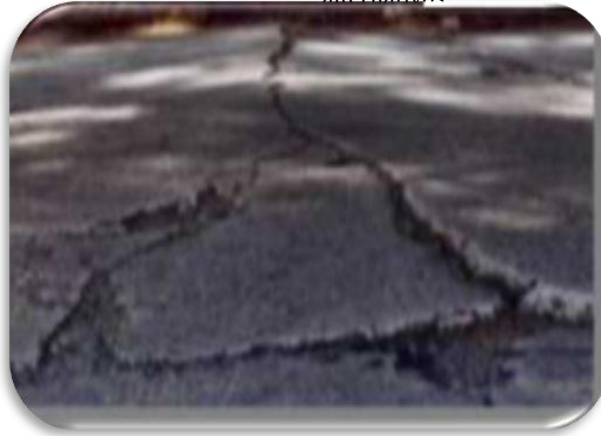
Figura N°6, levantamiento de losas.
