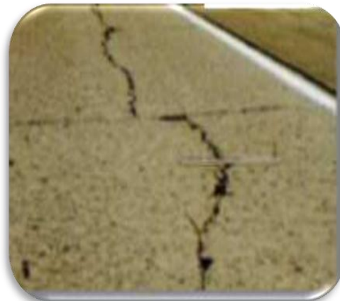
Figura N°4, fisura longitudinal.
