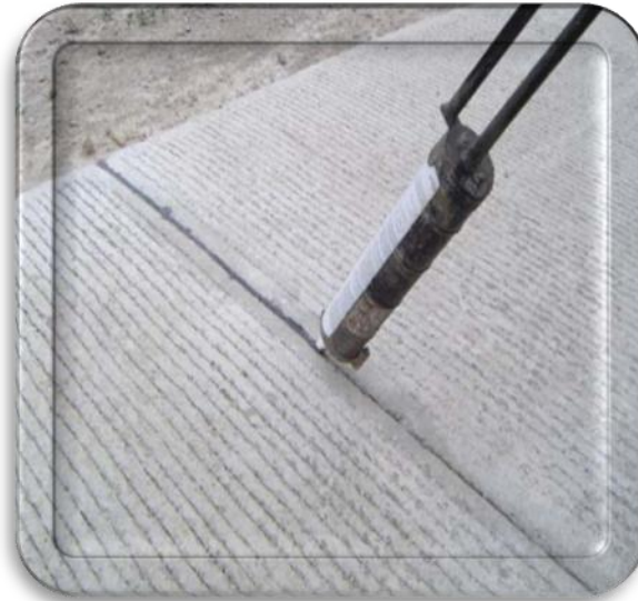
Figura N° 11 , juntas de contracción.
