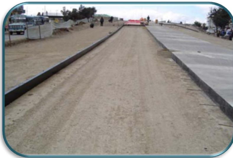
FIGURA N° 7, juntas longitudinales
