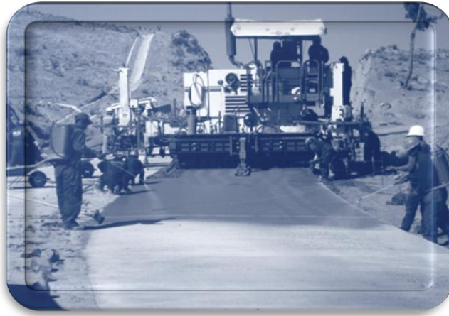
Figura N° 2, Colocado y curado de pavimento rígido.
