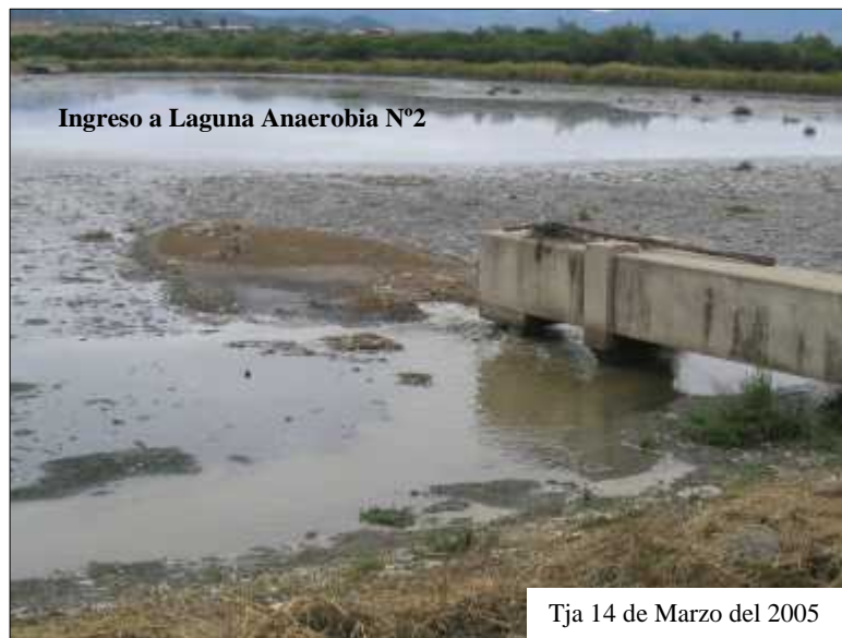
Figura 1.5.- Ingreso a la 2da Laguna Anaerobia (toma 1)
