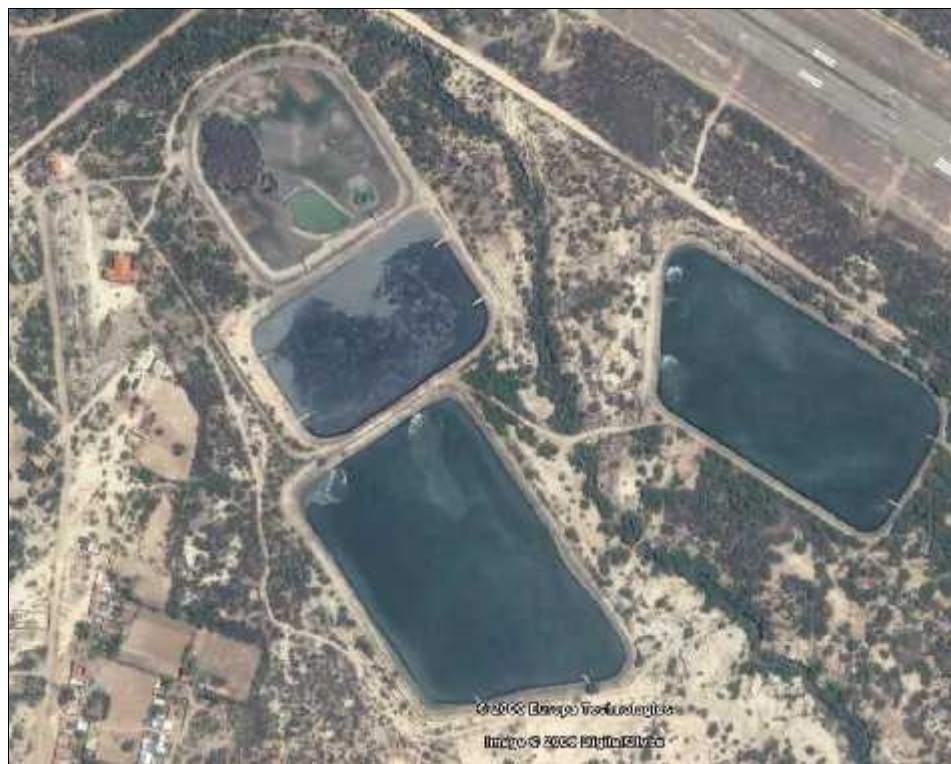
Figura 1.2.- Imagen Satelital-Lagunas de Oxidación
