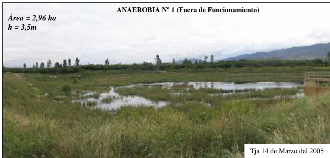
Figura 1.3.- Fotografía de Laguna Anaerobia N° 1
