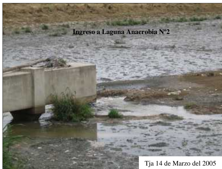
Figura 1.6.- Ingreso a la 2da Laguna Anaerobia (toma 2)
