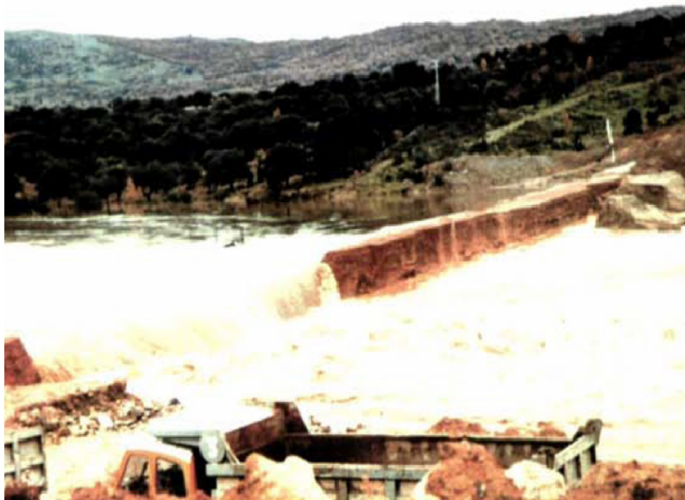
ROTURA DE LA ATAGUIA DE LA PRESA DEL JERTE POR SOBREVERTIDO
