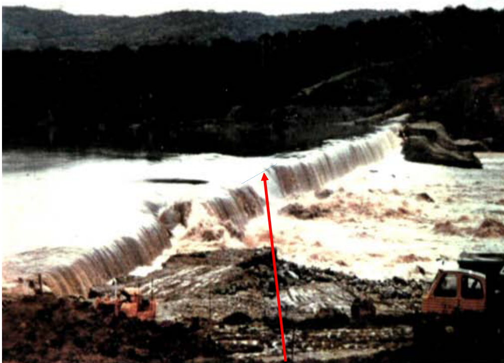
INICIO DE LA BRECHA DE ROTURA
