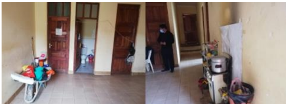
Figura 75 Interior de la Infraestructura
