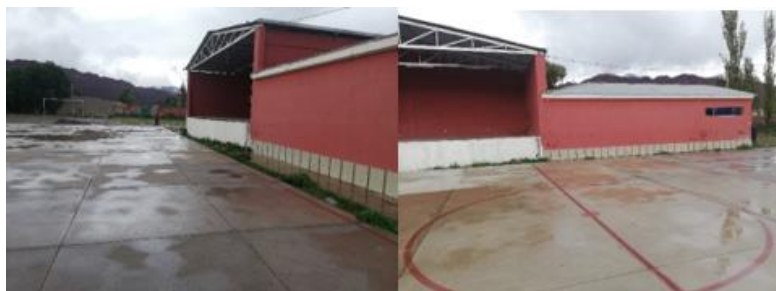
Figura 74 Infraestructura en el Terreno
