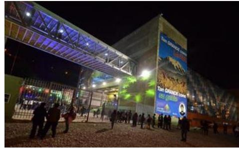
Figura 19 Vista de pasillo de Bloques del Chuquiago Marka
