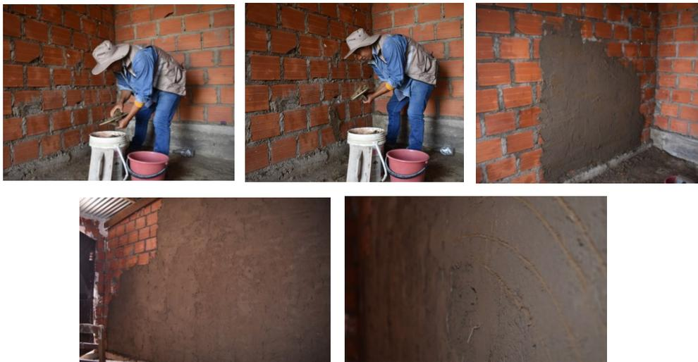
*Imagen 58 elaboración propia realizando la aplicación del revoque al muro interior de ladrillo*
