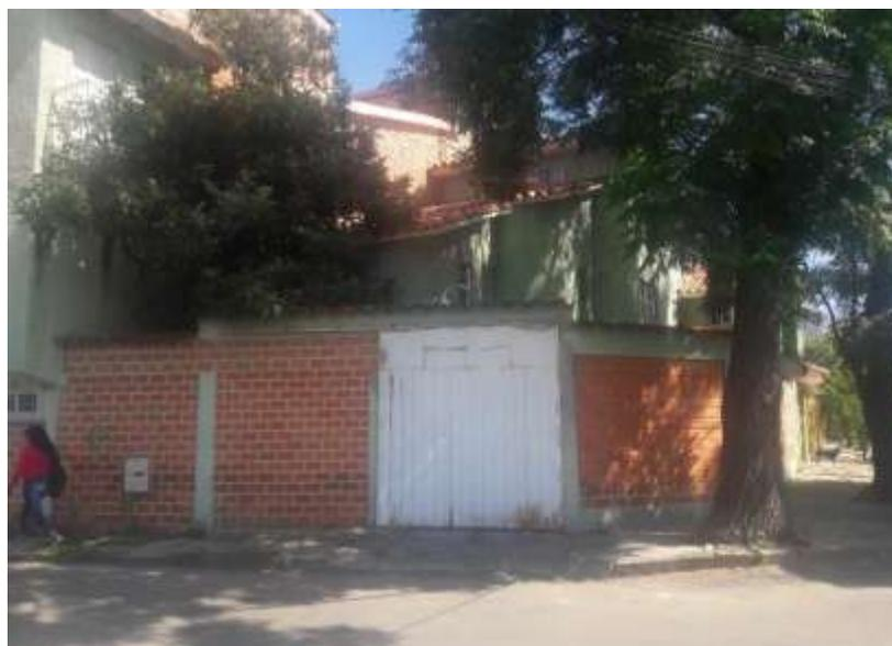
*Imagen 5.15. Cierre perimetral de muro de ladrillo y hormigón.*
