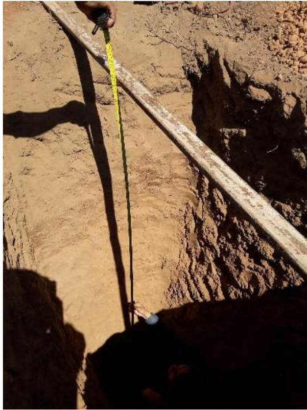
Figura Nro. 24. Calicatas con profundidad a 3 m
