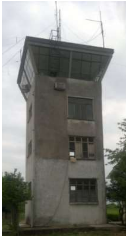
Figura Nro. 2. Torre de Control del Aeropuerto de Villa Montes
