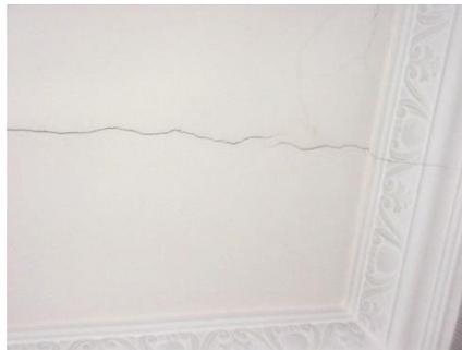
*Figura 2.14 Fisuración en longitudinal en la junta de la vigueta o viga y la bovedilla*
