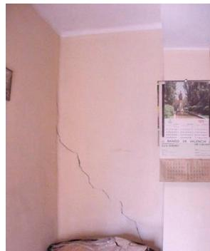
*Figura 2.15 Fisuración por acumulación de cargas en voladizos*
