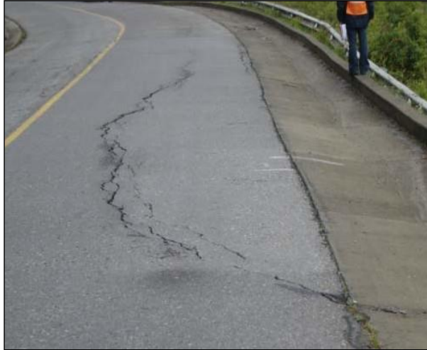
Gráfica N°8. Fisura en medialuna
