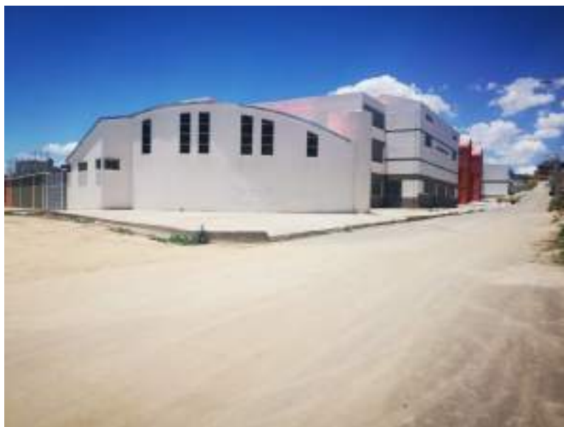
Ilustración 3.40 Calle n°5 sin señalización horizontal
