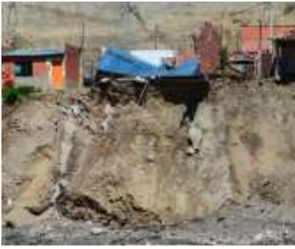
*Figura 59. Ejemplo de deslizamiento de viviendas.*
