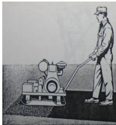
Figura 4.23 Compactando con un compactador vibrante-plano
