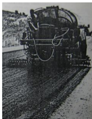
Figura 4.30 Aplicando un sello de lechada a la superficie
