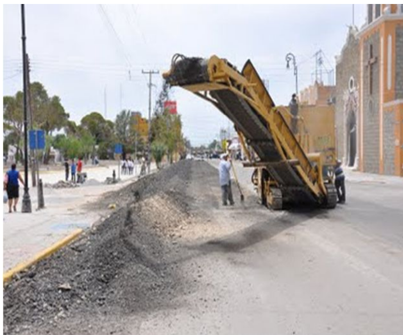
Figura 3.43 Retirado de pavimento flexible para ser reciclado
