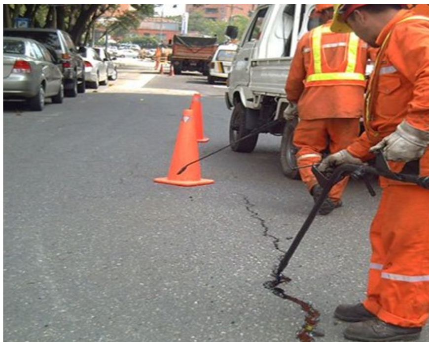
Figura 3.36 Sellado de una grieta longitudinal
