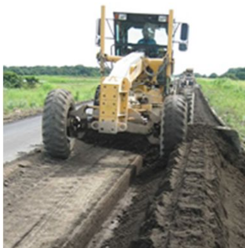
Figura 3.39 Reciclado de pavimento
