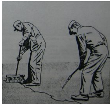
Figura 4.36 Recubriendo la superficie con arena seca
