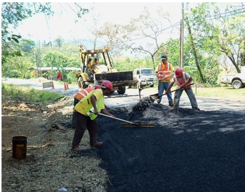
Figura 3.42 Mezclado de asfalto
