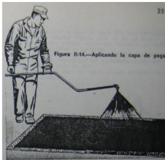
Figura 4.21 Aplicando la capa de pega
