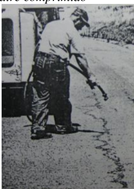
Figura 4.29 Llenando las grietas de encogimiento con sello de lechada
