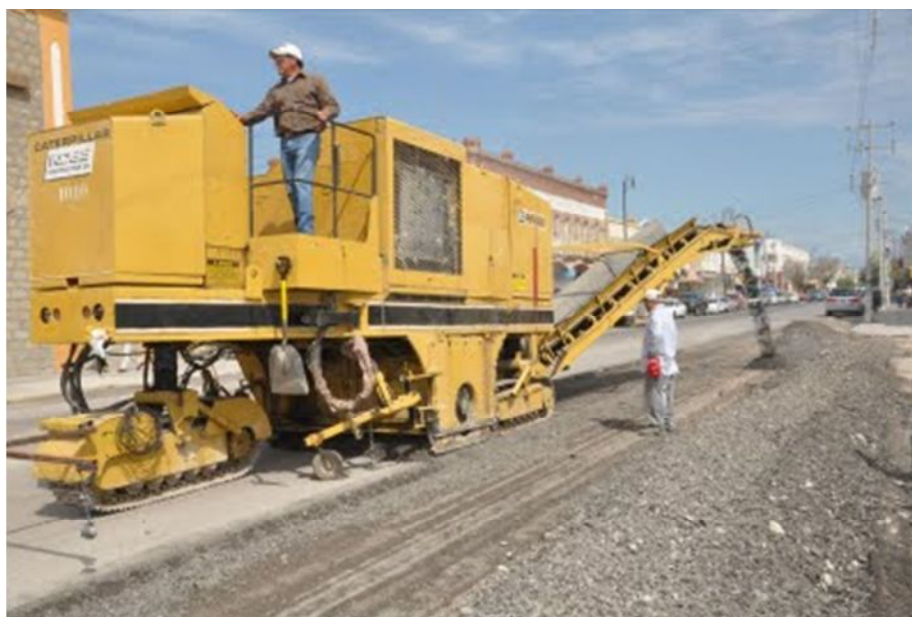
Figura 3.44 Retirado de pavimento flexible con maquinaria
