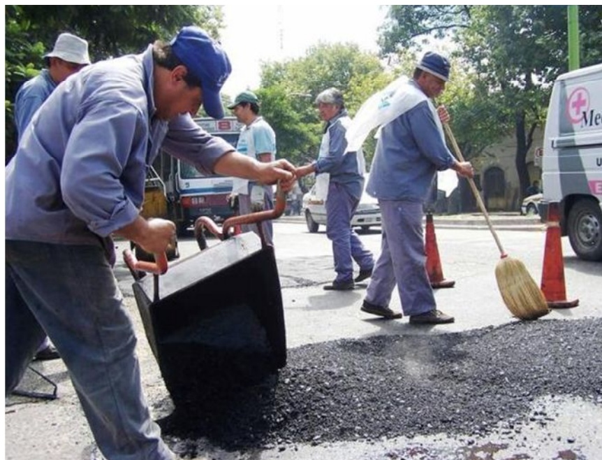
Figura 3.37 Preparación para el bacheado de una calle
