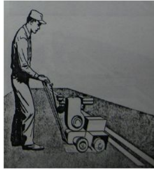
Figura 4.38 Demarcando y señalando un hundimiento Figura 4.39 Lijando un borde hundimiento
