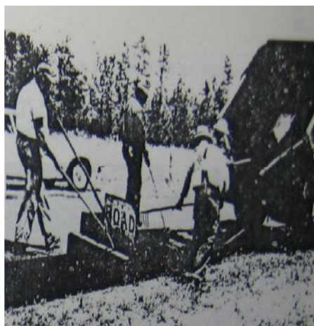
Figura 4.33 Compactando con una apisonadora
