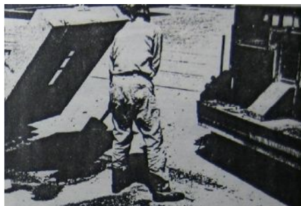
Figura 4.53 Llenando el hundimiento con mezcla almacenada
