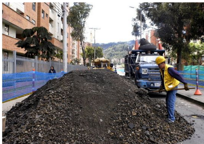
Figura 3.45 Reciclado de Pavimentos
