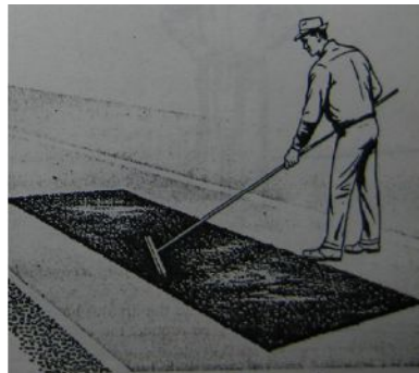
Figura 4.14 Extendiendo la mezcla
