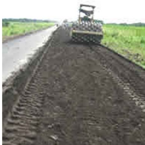
Figura 3.40 Remoción con maquinaria para el reciclado
