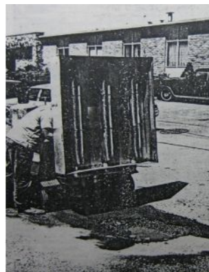
Figura 4.54 Usando el compactador vibrante plano
