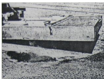
Figura 4.55 Secando el parche con el calentador infrarrojo
