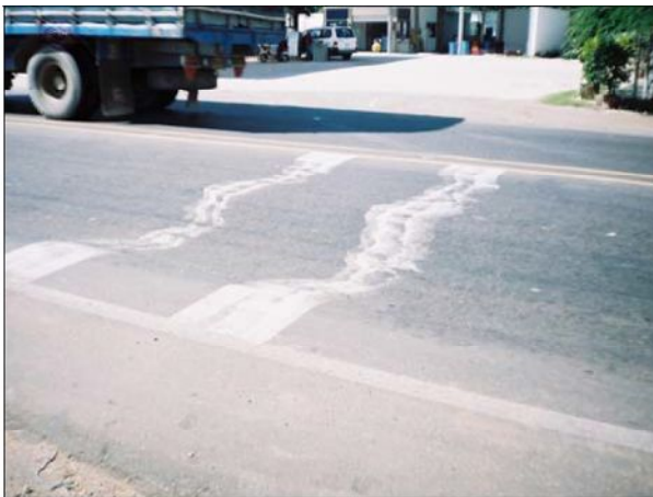
Figura 3.27 Falla por ahuellamiento de severidad media
