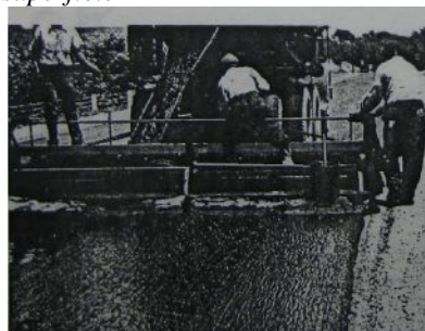
Figura 4.30 Aplicando un sello de lechada a la superficie
