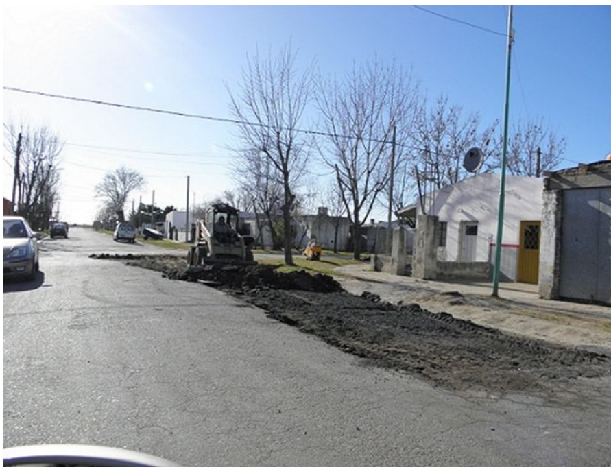
Figura 3.41 Preparación con maquinaria para el recojo del reciclado
