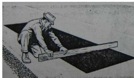
Figura 4.16 Nivelando el parche
