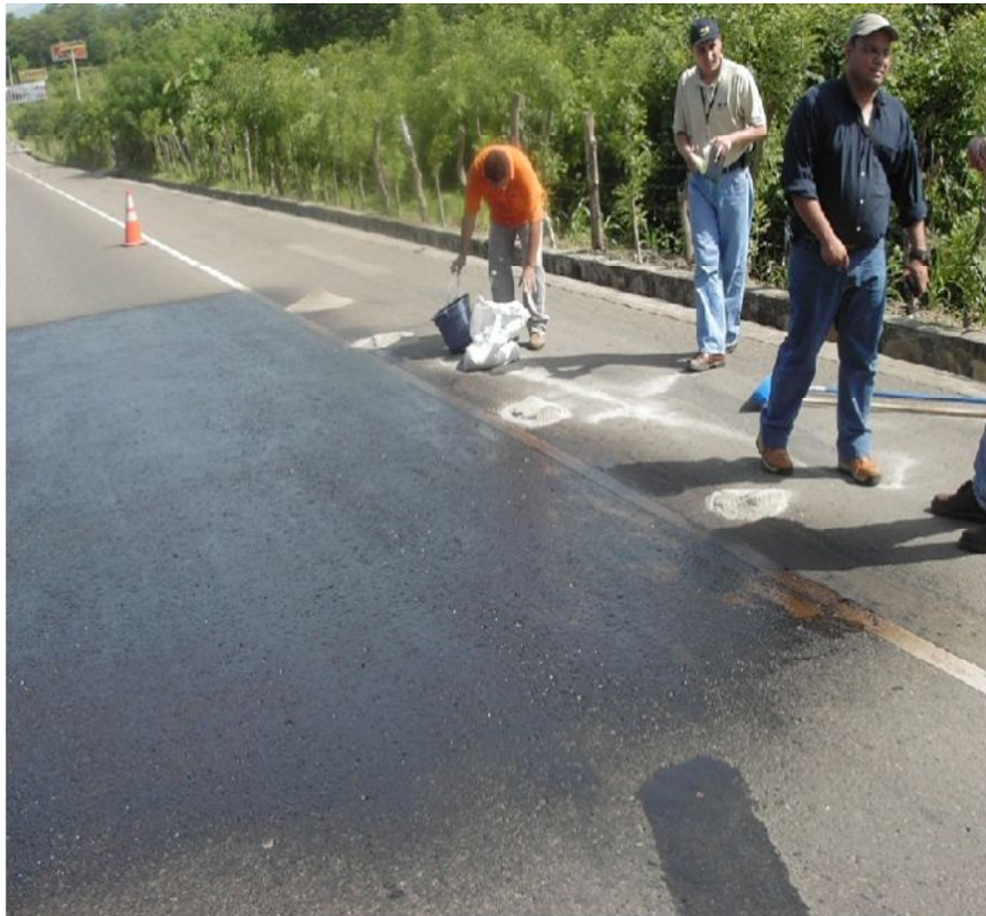
Figura 3.35 Echado de una capa bituminosa
