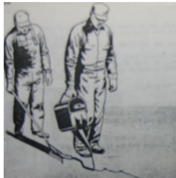
Figura 4.36 Recubriendo la superficie con arena seca
