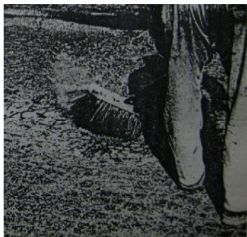
Figura 4.51 Limpiando el hundimiento del material suelto
