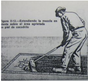
Figura 4.19 Extendiendo la mezcla en planta sobre el área afectada Figura 4.20 Compactando con un compactador vibrante-plano
