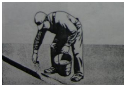
Figura 4.36 Recubriendo la superficie con arena seca
