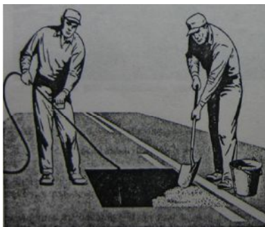
Figura 4.44 Colocando el sello de arena
