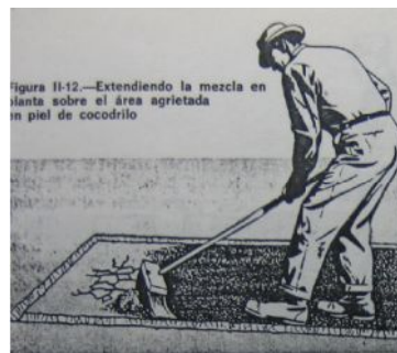
Figura 4.17 Cortando una cara vertical Figura 4.18 Extendiendo la mezcla en planta alrededor del área agrietada sobre el área afectada
