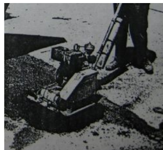
Figura 4.54 Usando el compactador vibrante plano
