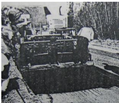
Figura 4.47 Extendiendo mezcla en planta densamente gradada
