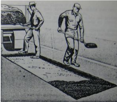
Figura 4.13 Rellenando el hueco con mezcla en planta
