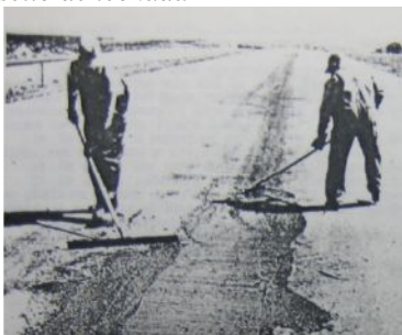
Figura 4.29 Llenando las grietas de encogimiento con sello de lechada
