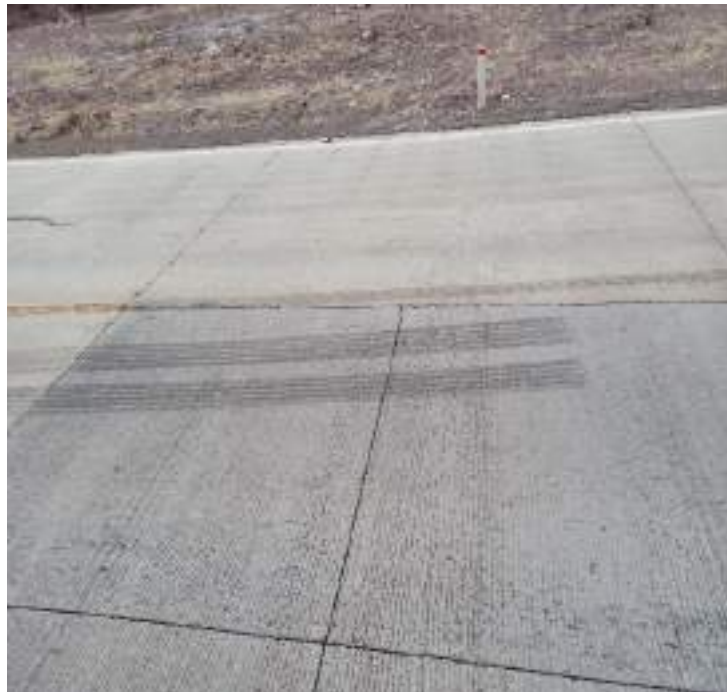
Figura 68: Mantenimiento de las losas
