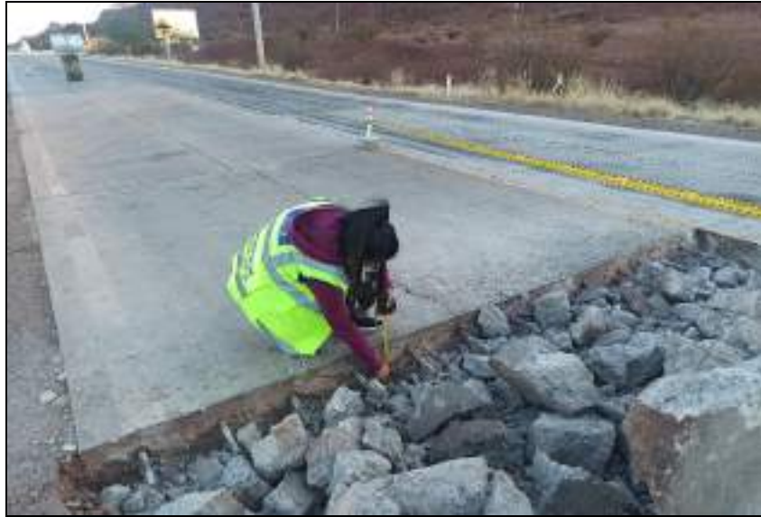
Figura 46: Medición del espesor de la losa de concreto
