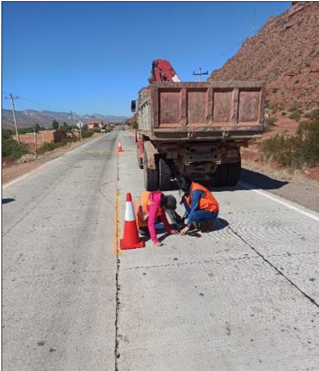
Figura 56: Calibración de la Viga Benkelman
