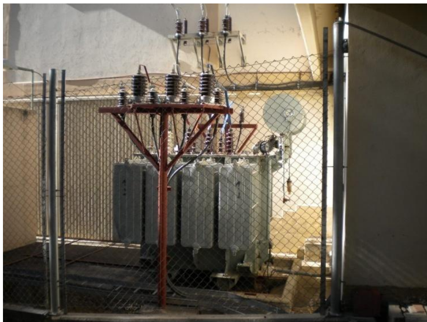
Imagen N° 3.9 Transformador Eléctrico
