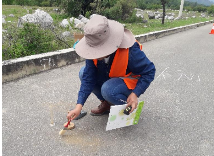
Figura 81. Limpieza del área de ensayo
