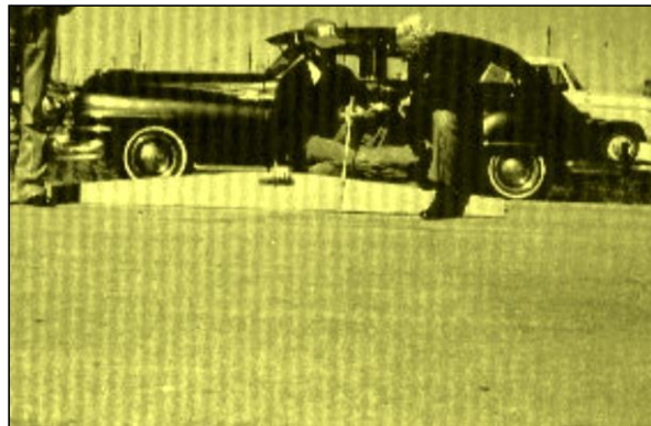
Figura 21. Depresión de baja severidad
