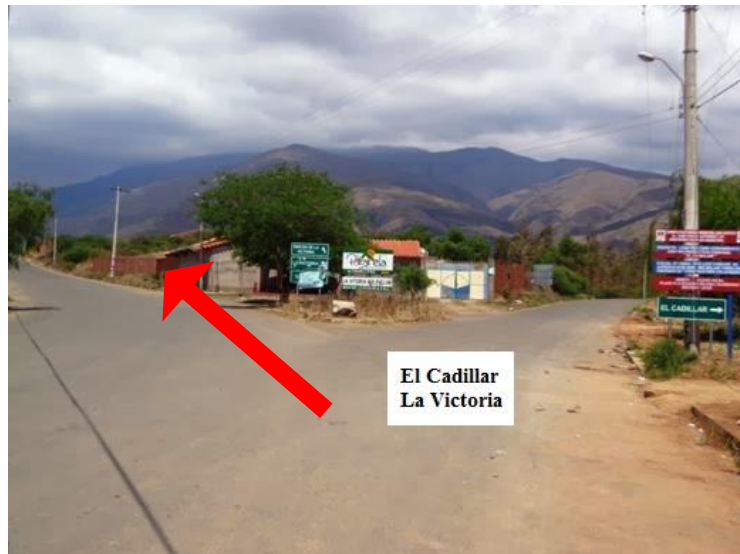
Figura 2. Pavimento flexible de la vía en estudio
