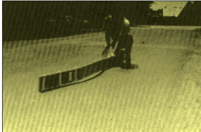
Figura 46. Desplazamiento de baja severidad
