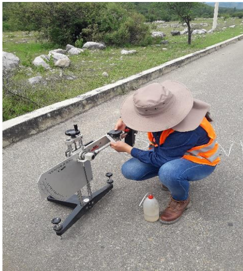
Figura 77. Colocación de la posición inicial del equipo
