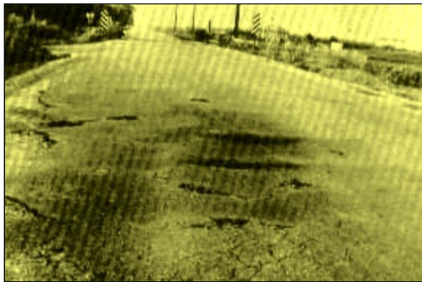
Figura 47. Desplazamiento de severidad media
